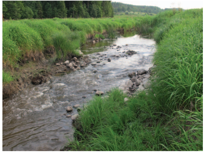
Figur 3. Bild från utläggning av lekgrus vid Hässelby i Kilaån. En kort strömsträcka har skapats i den annars mycket långsamt flytande ån. Foto: Ursula Zinko
