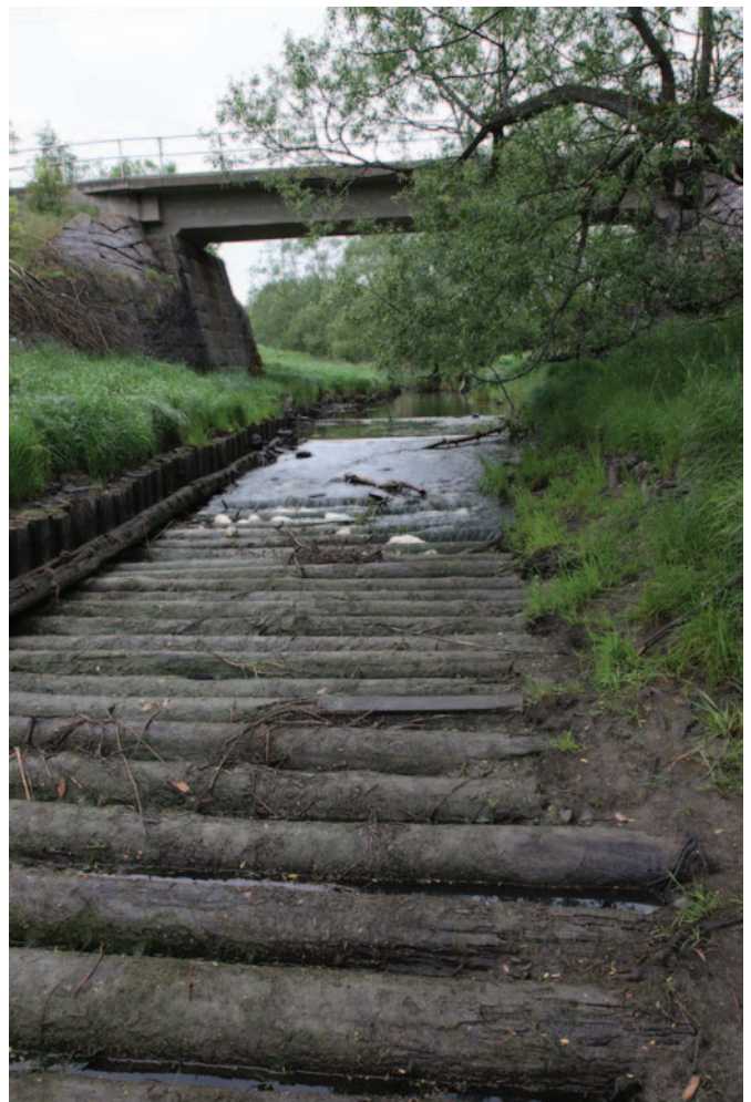
Figur 5. Partiellt vandringshinder vid järnvägsbron, Jönåker. Foto: Ursula Zinko
