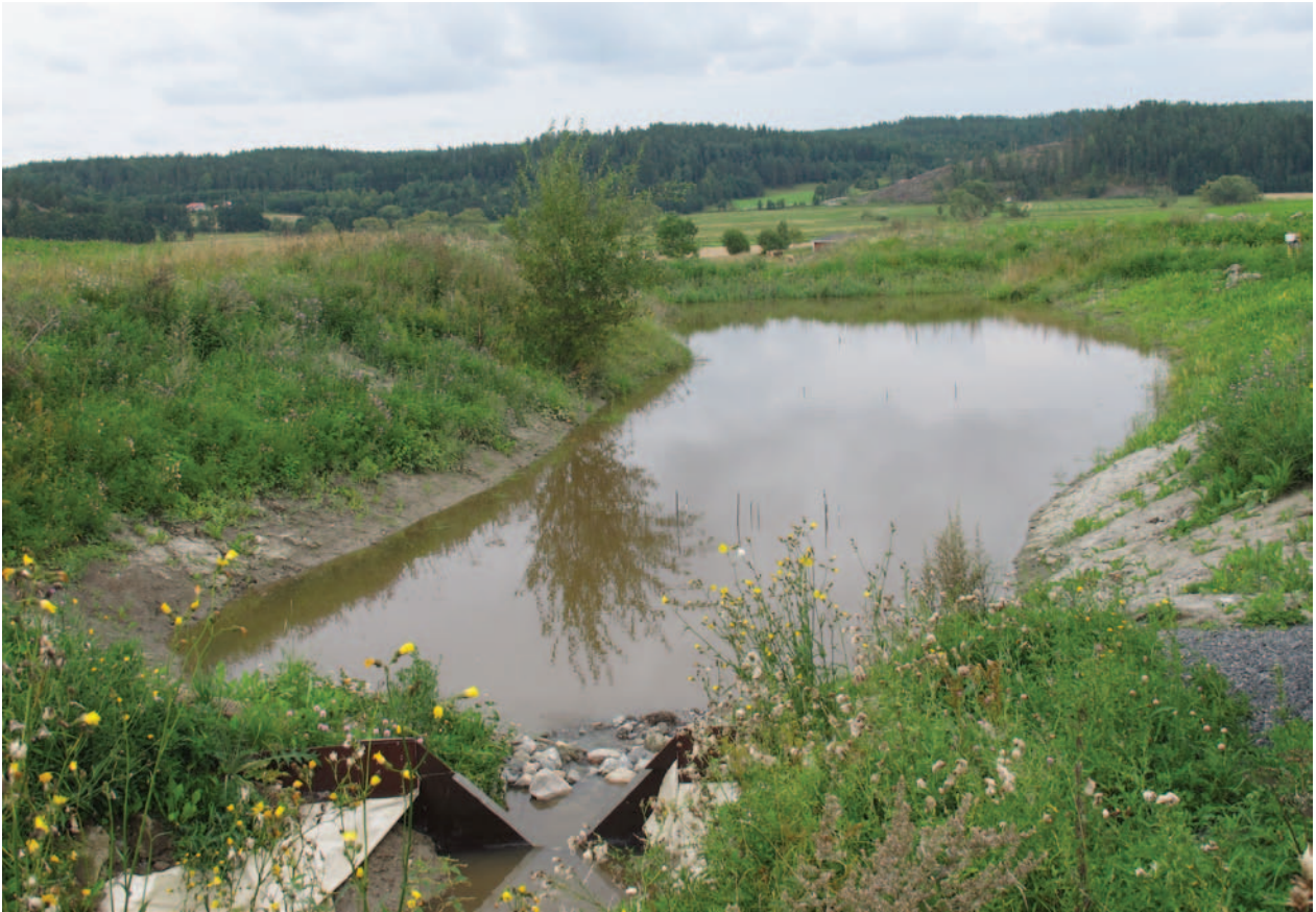
Figur 17. Vattnet leds först in i en djupdamm där sedimentet är tänkt att sjunka till botten. Foto: Ursula Zinko
