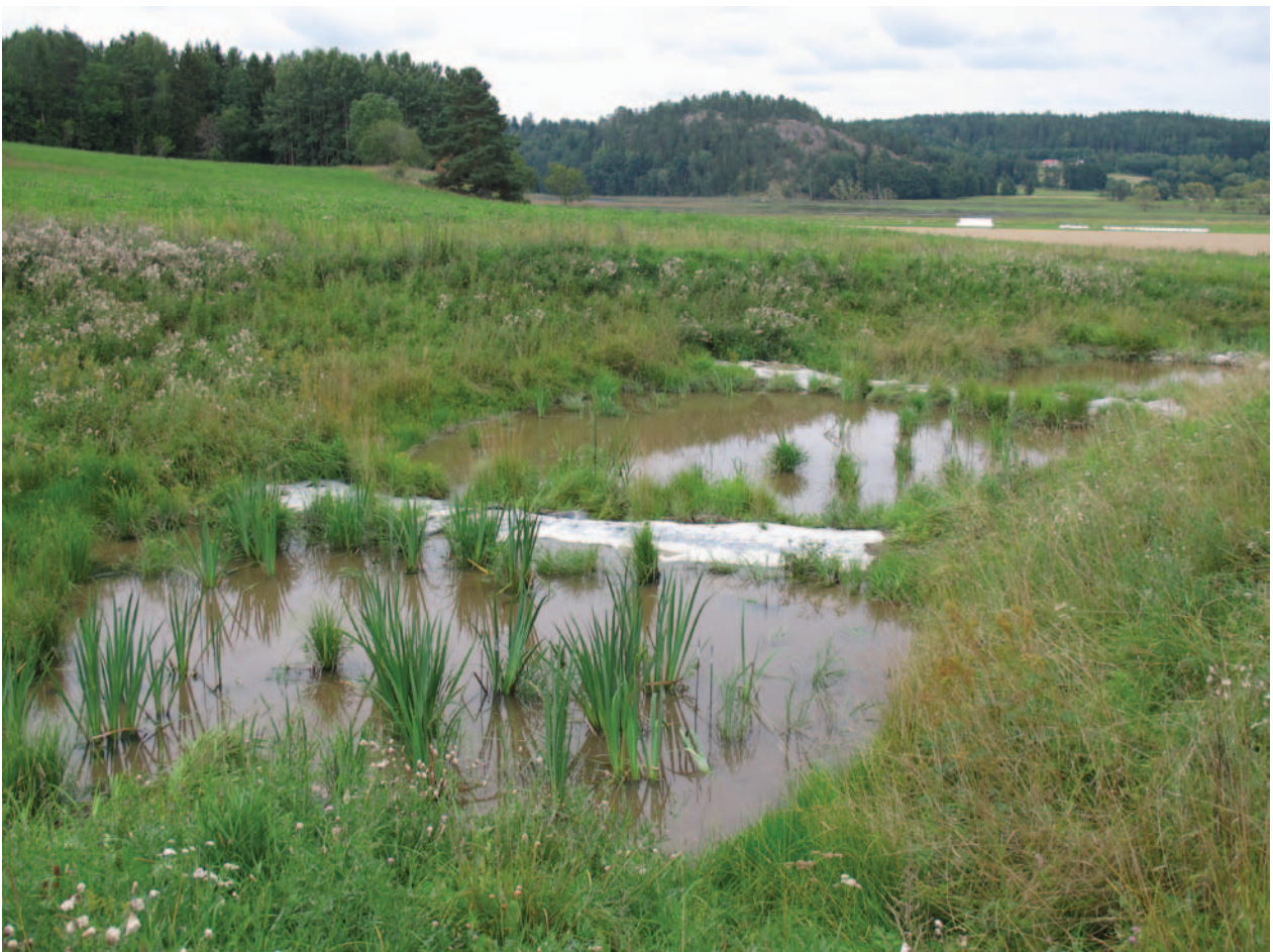
Figur 18. Från djupdammen leds vattnet ner till grunddammarna där växter planterades. Växterna tar upp näring från sedimentet och vattnet. Dessutom avsätts en del suspenderat sediment på växterna. Foto: Ursula Zinko
