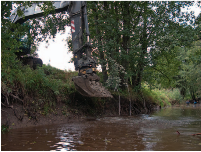
Figur 2. Lekgrus samt större sten lades ut i ån med hjälp av grävskopa. Eleverna hjälpte till att sedan fördela materialet över botten. Foto: Nils Ljunggren
