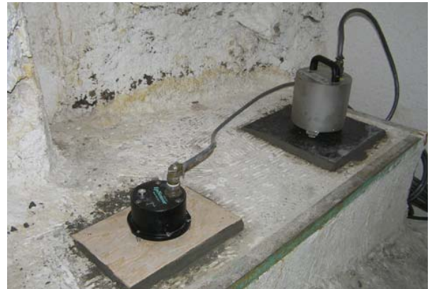
EpiSensorul ES-T și sensorul seismic BB CMG-40TD de la stația seismică Soroca
