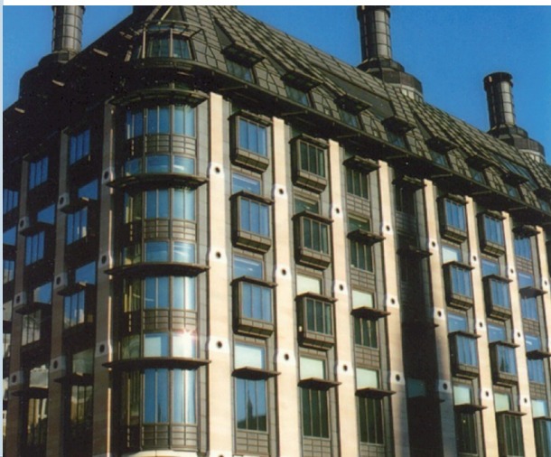
La londinese Portcullis House (progetto Michael Hopkins and Partners): per la copertura e gli infissi sono stati impiegati bronzi all'alluminio, contenenti l'80% di rame.
