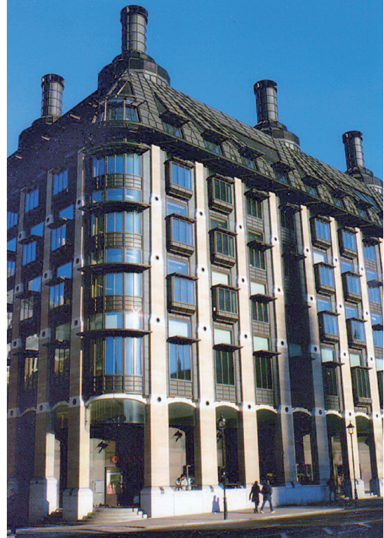
Fig. 8 Portcullis House contiene i nuovi uffici per i Parlamentari inglesi. Le sue "torrette" e la copertura sono ricoperte da elementi in bronzo all'alluminio (rame all'80%) di 6 mm di spessore (arch. Michael Hopkins and Partners, 2001).
