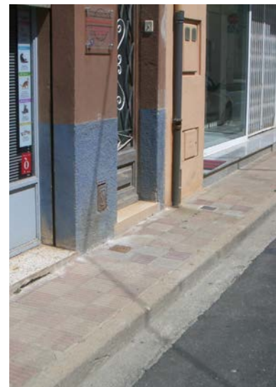
Per accedir a molts comerços cal superar l'alçada de la vorera i l'escaló d'entrada al local
