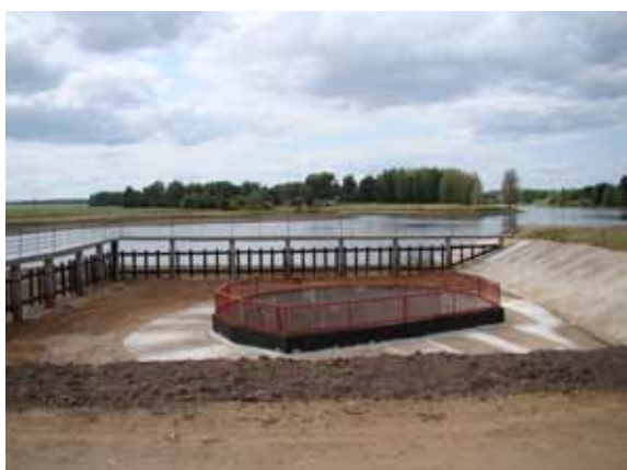
Фото 3. Капитальный ремонт ГТС на р. Ашланка у д. Ашлань-Вершина Мари-Турекского района
