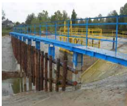
Фото 4. Капитальный ремонт ГТС на р. Пуют у д. Пуял Оршанского района
