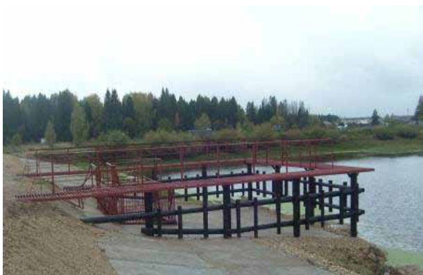
Фото 1. Капитальный ремонт ГТС на сухой балке у дер. Краснооктябрьский Медведевского района
