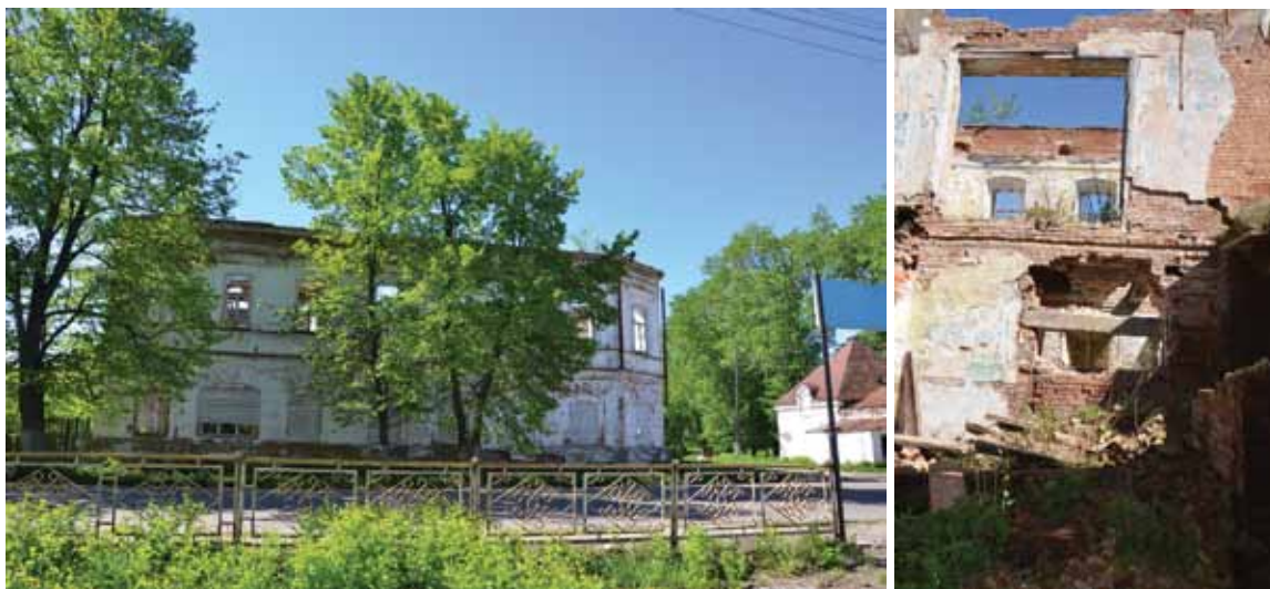
Фото 10. ОКН «Дом Голубева» (ул. Лихачева, д. 6): а – фасад дома; б – фрагмент дома с разрушенными перекрытиями, утраченной крышей. 21.05.2013
