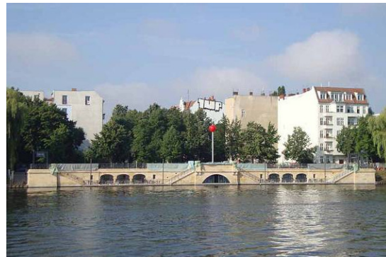
Erneuerung der Doppelkai-Anlage May-Ayim-Ufer 24
