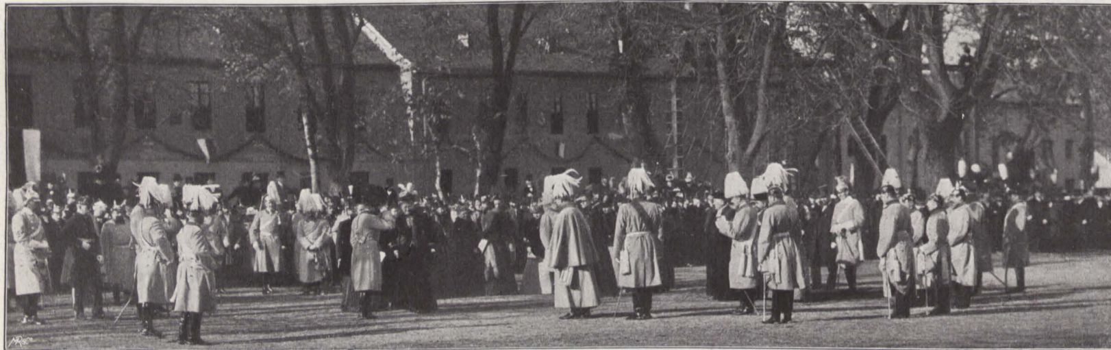
Bei der Grundsteinlegung der neuen Anstaltskapelle.
