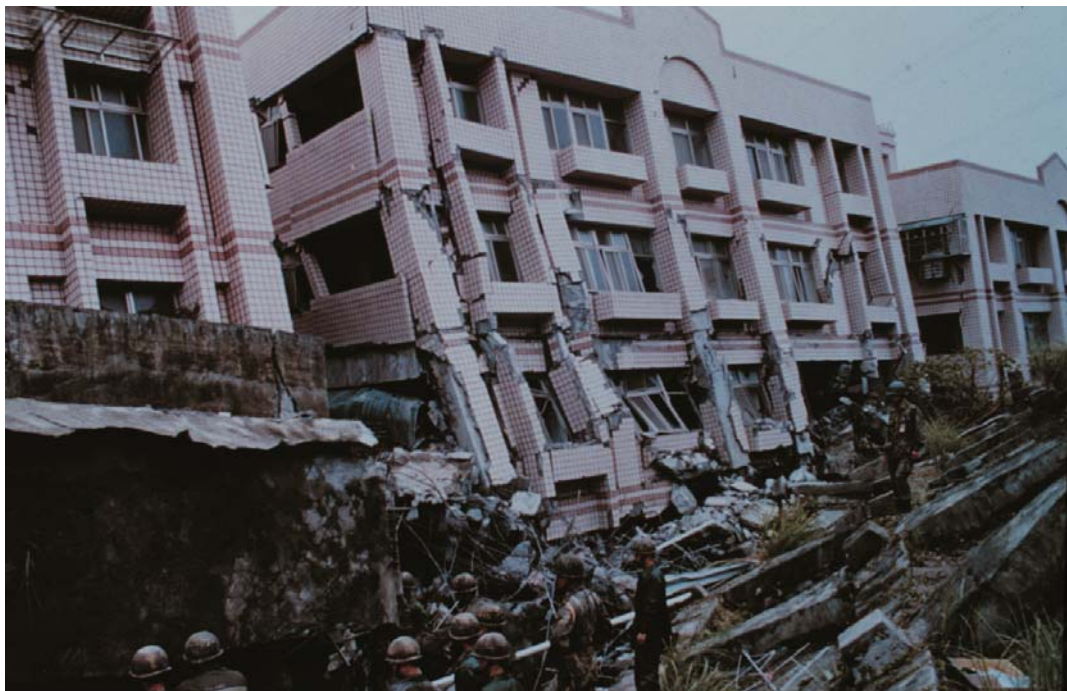
第3區的大樓受到地層滑動的衝擊，房屋結構本身嚴重龜裂扭曲。
