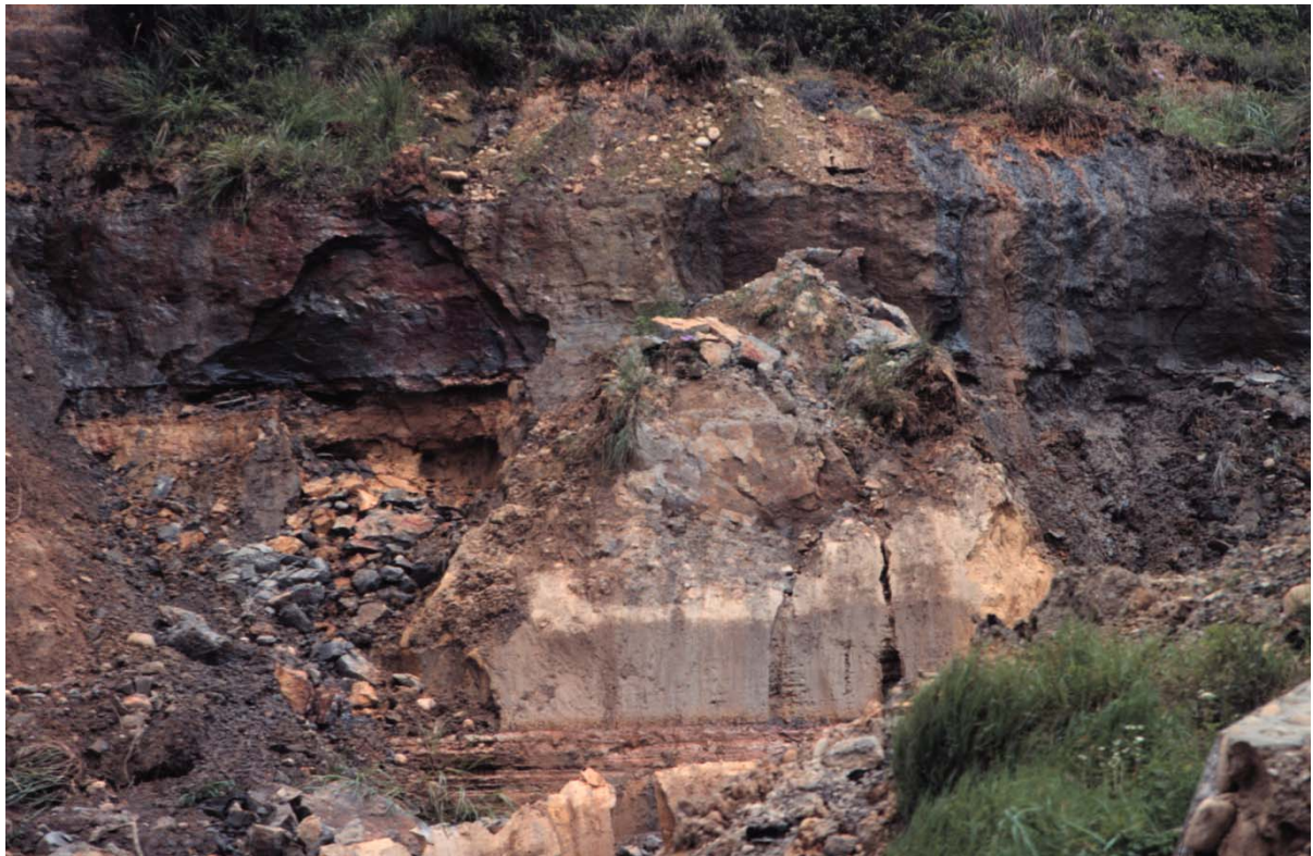
崩塌區內下部出露的為照門段岩層，以砂岩和泥岩為主，在台地邊緣之崩崖或侵蝕谷常見到露頭。砂岩為膠結不佳、強度低的黃棕色泥質厚層砂岩，偶夾氧化鐵薄層、薄碳層和黏土層。泥岩層呈灰色，岩性緻密，透水性差，最上方則為紅土礫石層。
