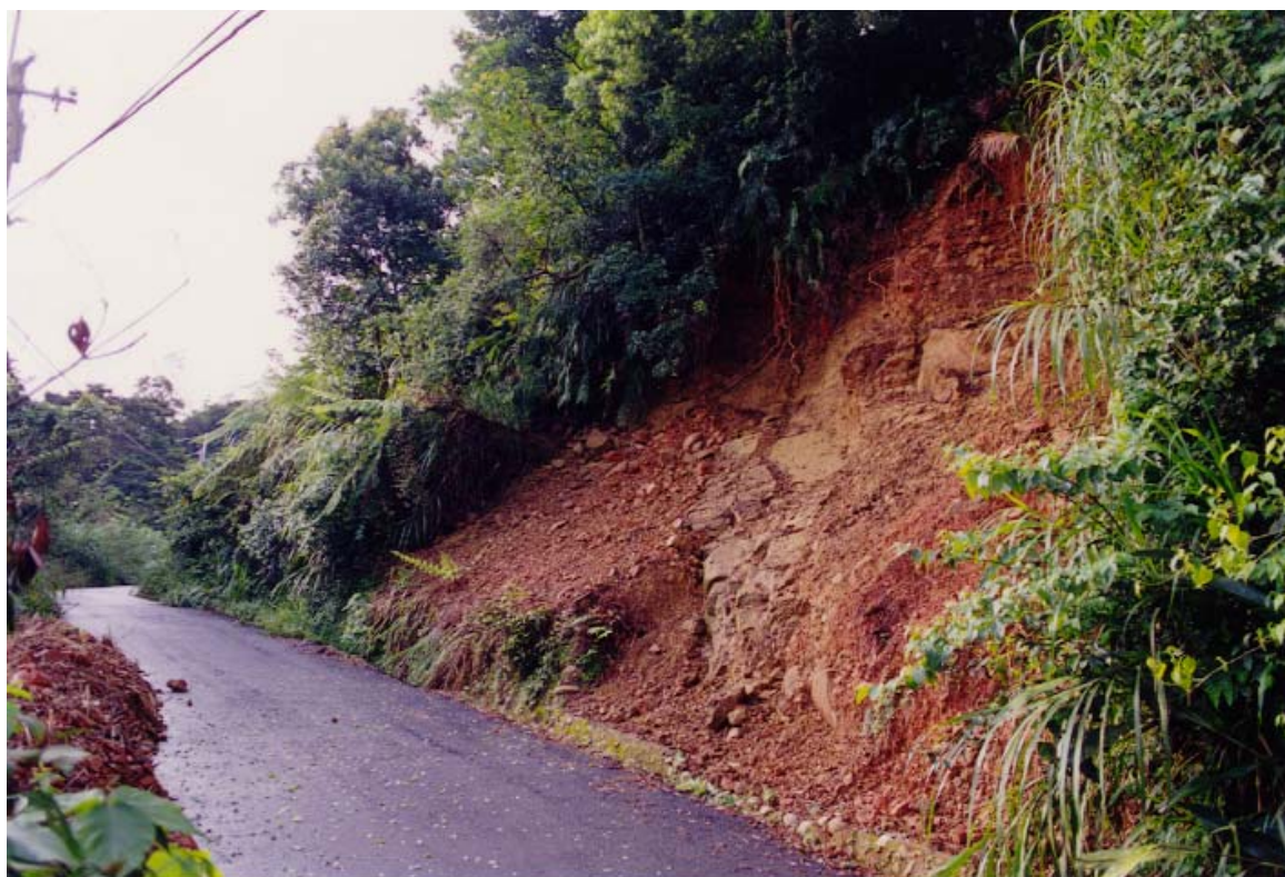
造成此次山崩災害的源頭，起初僅是由太平村連接電信局微波台的連絡道路發生邊坡坍方。此坍方為表層高度風化的土壤與岩屑，順著砂岩層面滑動。
