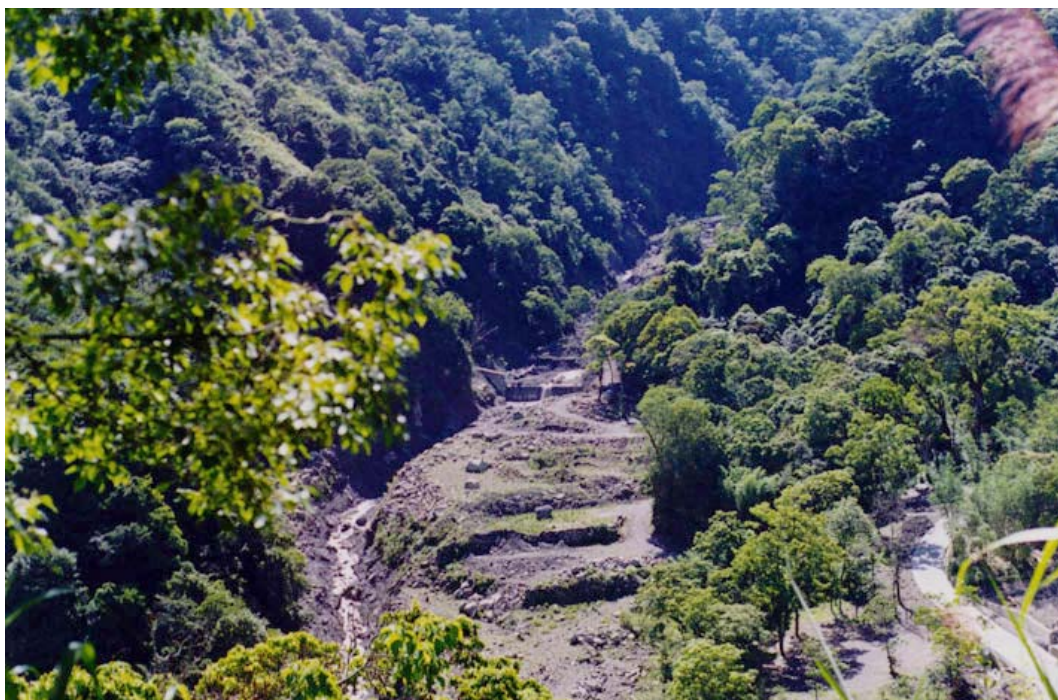
遠眺二號攔砂壩及目前河道流路，河床右岸尚堆置賀伯風災帶來之巨量土石。
