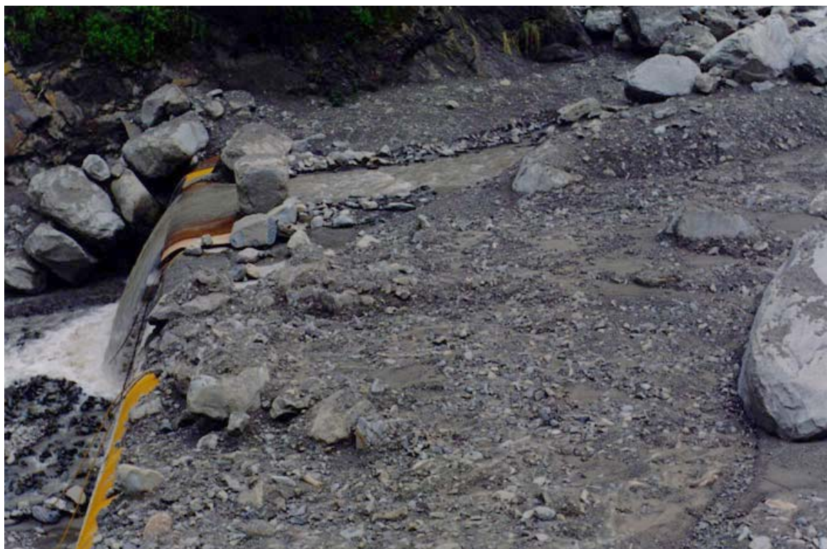
一號攔砂壩上多堆置細顆粒砂土，砂石粒徑多在10 cm以內，含礫量約40%，在巨石上則有砂土殘積。
