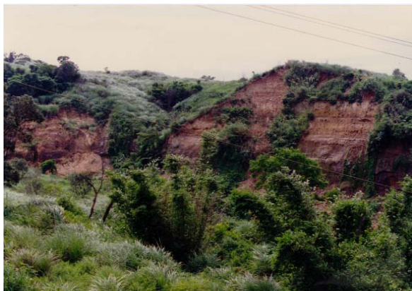
崩塌區西側陡崖與侵蝕溝二側崩崖，由泥岩與紅土礫石層組成，山崩屬於墜落型。
