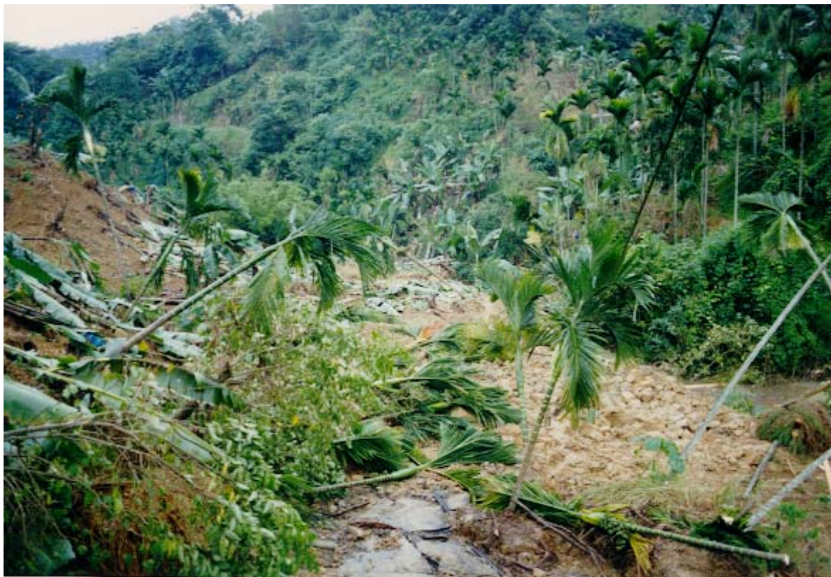
雙坑產業道路因山崩而滑入溪谷中，對外交通中斷。當地居民在滑動區附近多種植檳榔、香蕉和柑橘等淺根性經濟作物，
