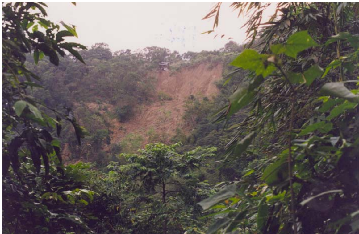
第2處崩塌地距一號崩塌地上游約五十公尺，崩塌地的規模甚大，崩塌範圍由山頂至溝底，高差有五十公尺以上，縱長在一百公尺以上，寬有三、四十公尺，滑動的材料屬於風化的土、岩屑塊為主（分佈圖 p-6）。
