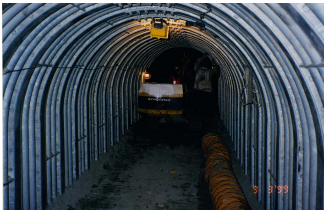
正在施工中的排水廊道整治工程。
