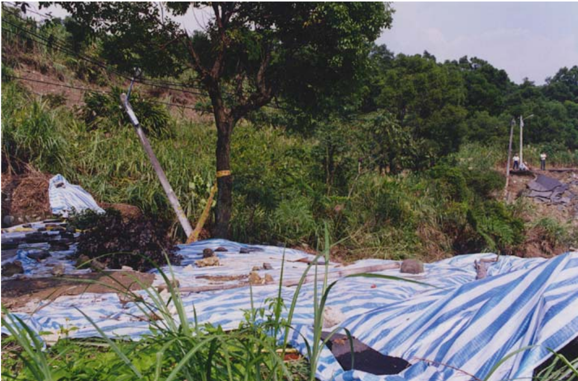
三號崩塌地的頭部位於長春路產業道路的上方斜坡，以致造成道路產生坍塌的情形（分佈圖 p-9）。
