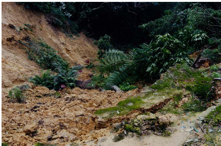
崩塌地之上緣土層崩移情形。
