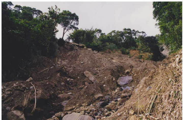
位於第3和第4處崩塌地下方溝內，佈滿大小不同的岩塊，和崩落的土、石材料與破壞的擋土結構（分佈圖 p-8）。
