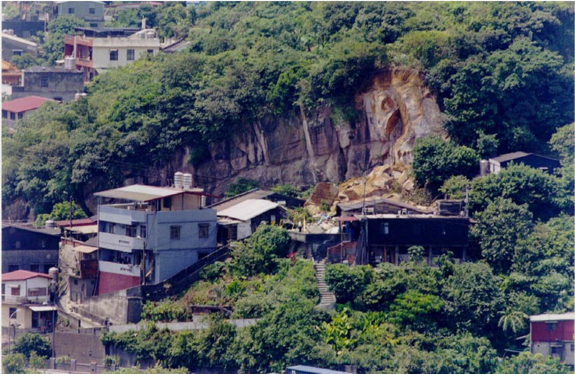
基隆市中山二路落石災害現場，巨大石塊自山壁崩落而下，壓毀三棟民宅，導致居民一死一傷的慘劇。
