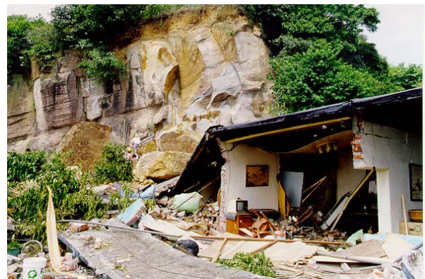
巨石崩落直接壓毀下方木造平房，照片中巨石底下之民房已被夷為平地。
