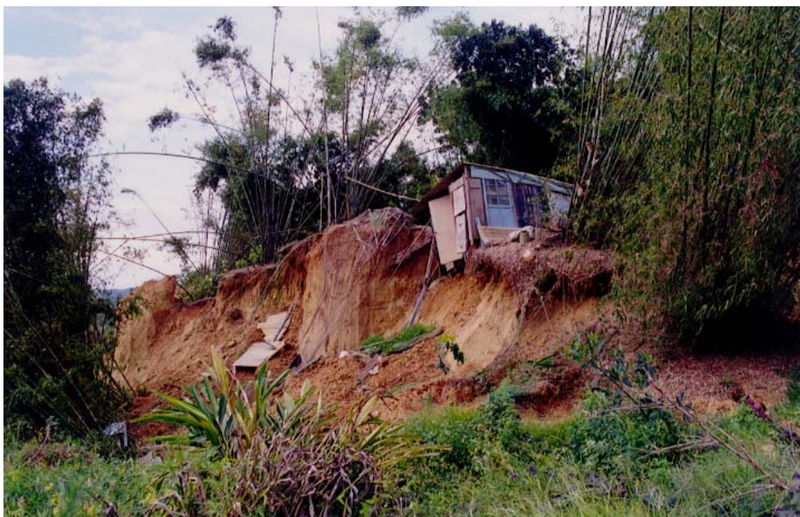
八月十三日龍崎兵仔舍再度山崩，崩崖已向後發展至稜線後方，造成另一棟農舍的破壞。
