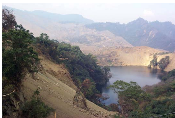
崩積區南緣的韭菜湖溪堰塞湖，湖後方即為山崩造成之土堤。
