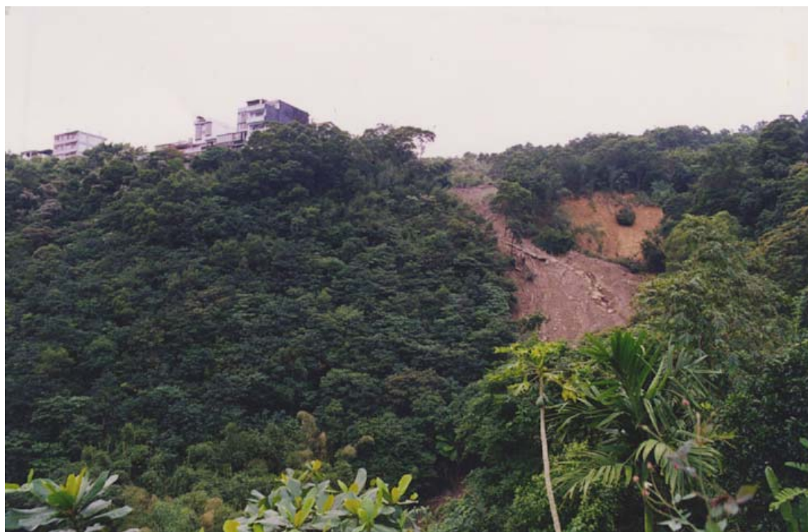
第3與第4處崩塌地位置，左側為第3，右側為第4（分佈圖 p-9）。
