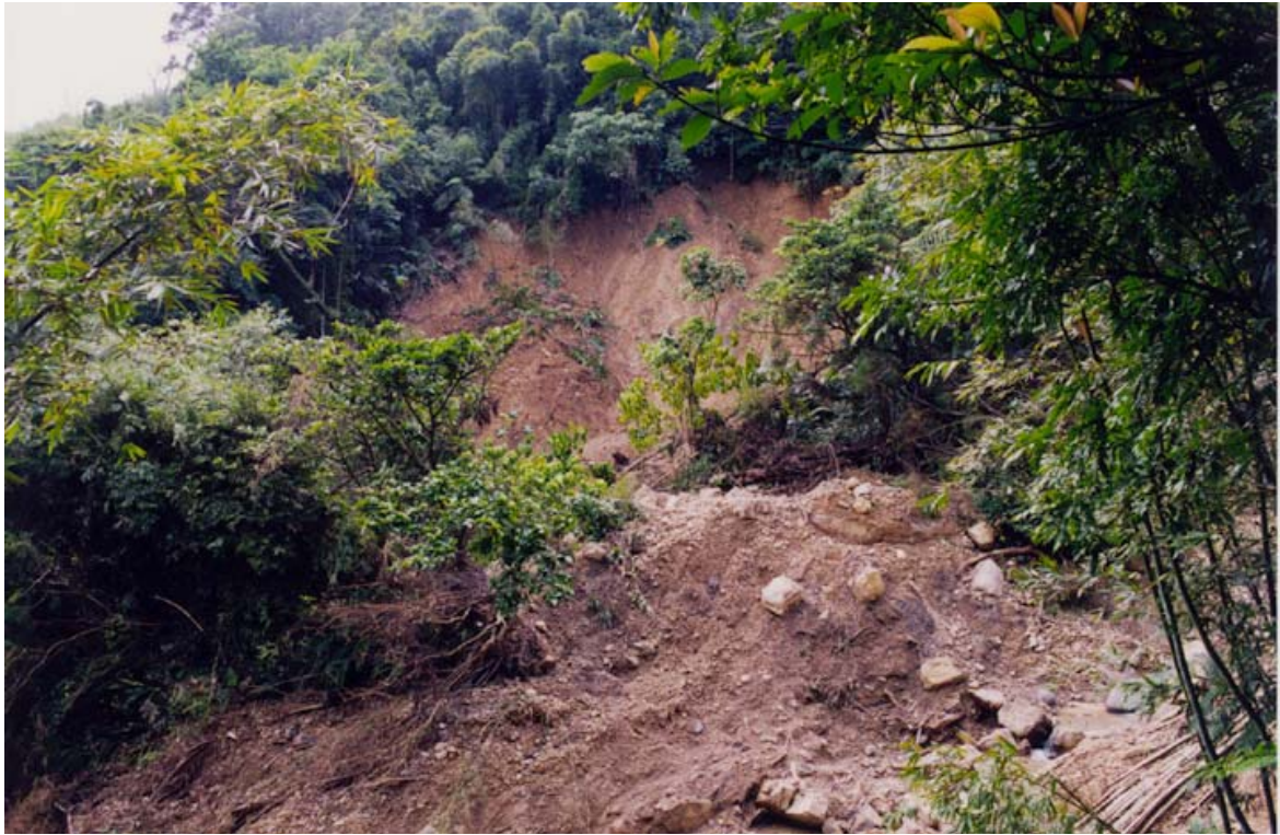
位於攔砂壩西側第1處崩塌地，崩塌的範圍寬約30公尺，高約20公尺，為風化岩屑的圓弧型滑移（分佈圖 p-5）。
