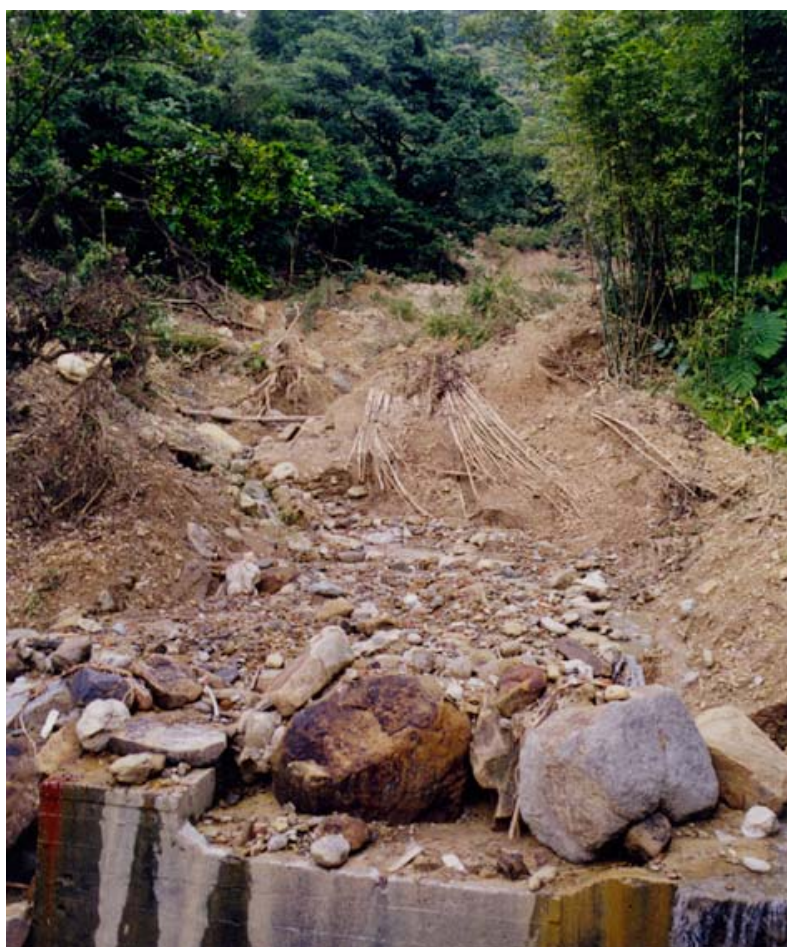
攔砂壩後，溝中可見有大量的土石堆積物（分佈圖 p-5）。
