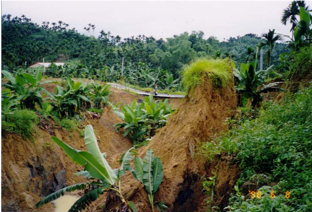
位於崩崖與崩滑體間之低陷區，因滑動時拉張，而使得地表發生下陷。此張力裂隙寬約3~5公尺，深約4~5公尺。本區上部為黃棕色表土和風化砂岩組成的風化岩層，下部為灰色砂岩或粉砂岩與頁岩互層的新鮮岩盤（照片左下）。（王文能 攝）
