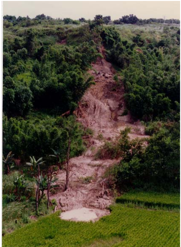
崩塌區西側陡崖上墜落的土石，在飽含水後，成為土石流或泥流向下流動。
