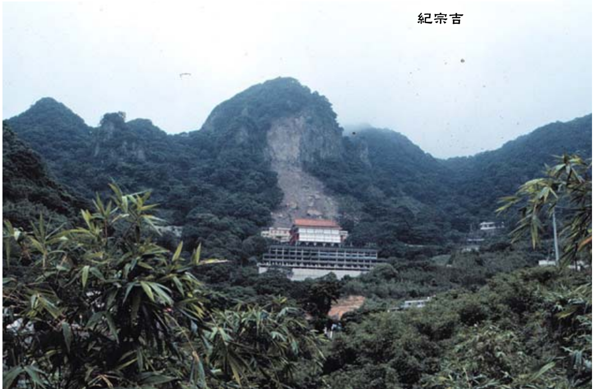
觀音山凌雲禪寺後方山坡山崩全景。總計重達數千噸以上的石塊自山頂直奔而下，衝毀部分寺廟。
