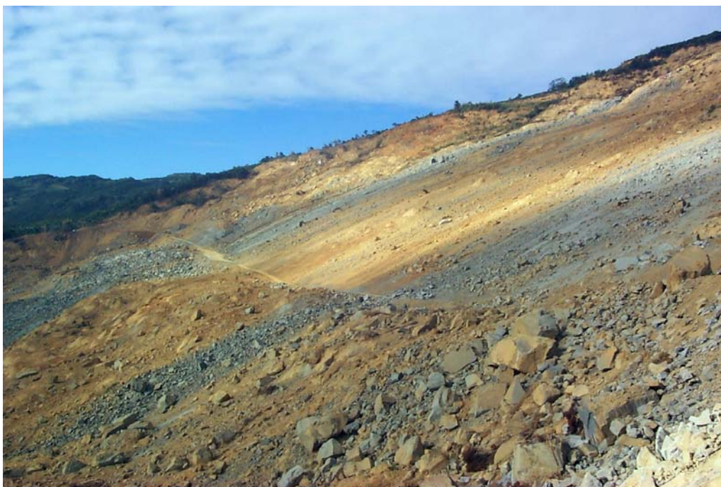
滑動邊坡上之材料：黃棕色為表土及崩積層，其下為灰黑色頁岩夾砂岩。
