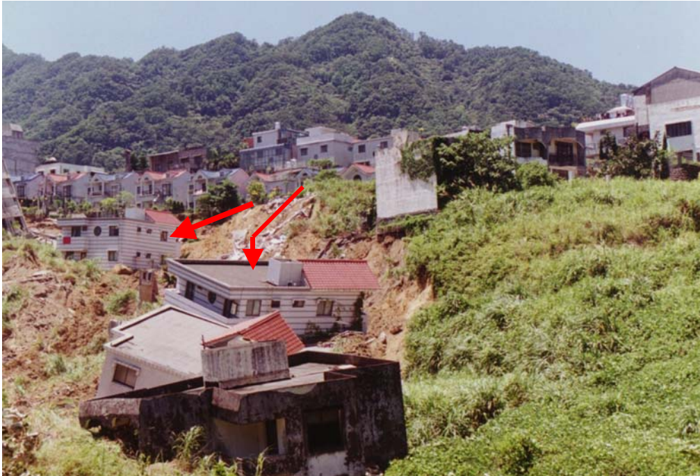
自然清境社區內之別墅沿舊河谷崩塌滑落，望之觸目驚心。
