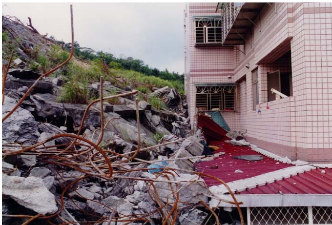
覆蓋在B滑動體上的地錨格樑因表層滑動，而滑落衝入民宅，成為2區災變的主要原因。
