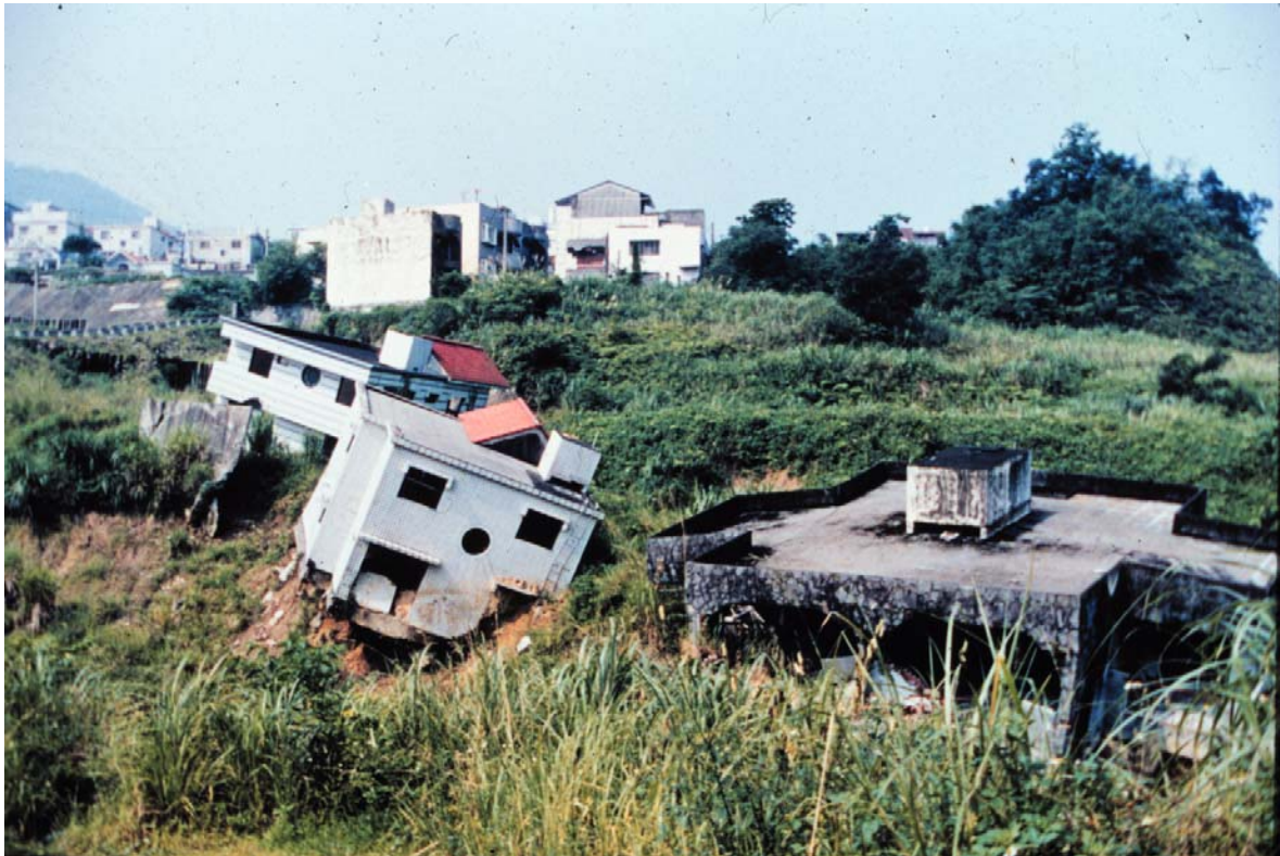
三峽白雞自然清靜社區房屋滑動現場，二棟白色樓房自後方擋土牆處滑移至現在位置。
