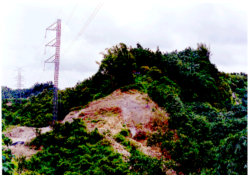
326電塔現場滑動後地形及原地搭建之臨時塔基。
