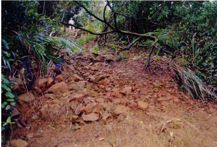
邊坡坍方的土石越過道路，滾滾而下。人立處即為道路坍方位置，下方為部份殘留在坡面上的坍方岩塊。
