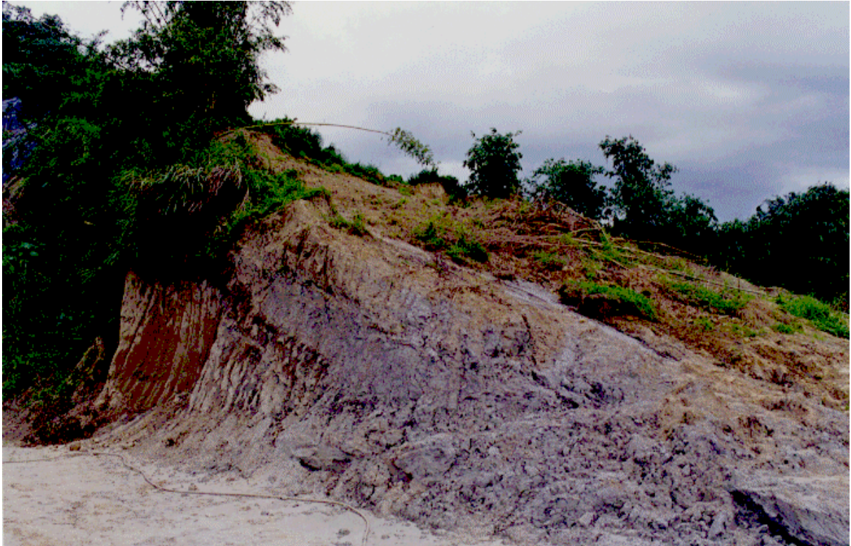
出露於326塔基下方之頁岩及厚砂岩層，膠結均不佳，易於風化與崩解，頁岩上方的厚砂岩已滑落，露出滑動面情形。
