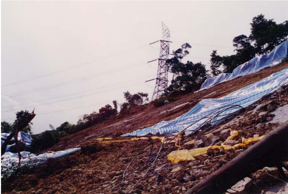
B滑動體表層滑動情形，地錨格樑已滑落，地錨鋼纜殘留於坡面上，顯示錨頭鬆脫所致。
