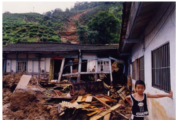
崩塌的土石順著三合院後方茶園的蝕溝，直接衝到山下，甚至湧至前院，整座三合院幾乎為土石所淹沒。
