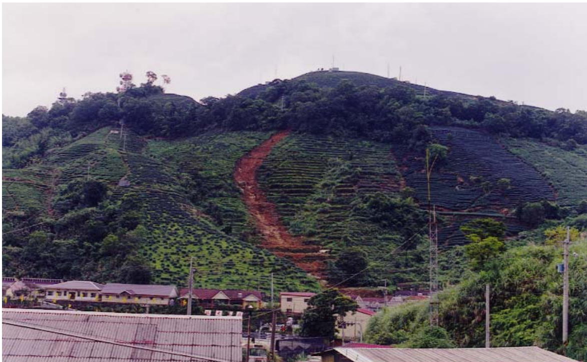
受災房舍後方茶園由山腰處，形成一條長220公尺，寬34公尺，深1~2公尺的侵蝕槽溝，崩滑的土石即是順此槽溝一路沖毀茶園、人工磊石土牆和山下的房舍。槽溝右側(長草處)為上次崩滑者。
