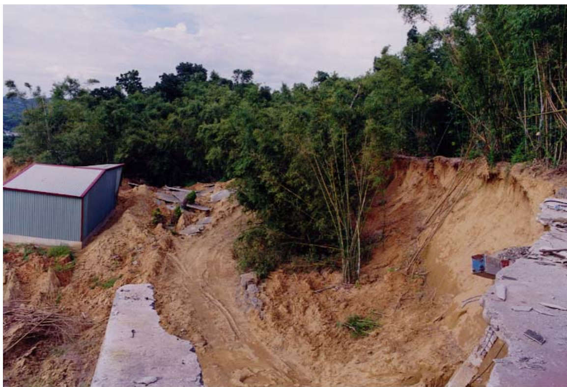
八月十三日因連日降雨不斷，於上述地點再次發生山崩，崩崖後退數十公尺，使得原先路旁農舍隨之滑陷。
