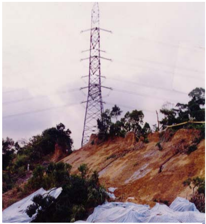
滑動岩塊上所造成之數條開口裂隙。
