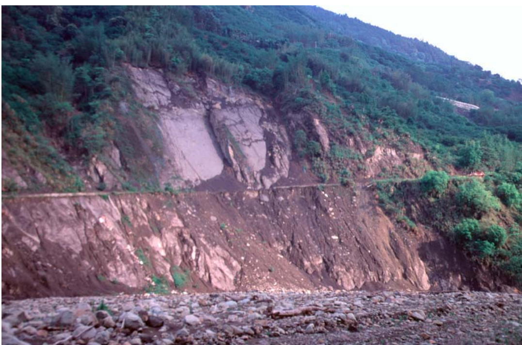
同富附近和社溪左岸出露之和社層呈順向坡地形 (A) 及和社層順向坡之近景 (B)。產業道路之開發及其他人類活動，常造成風化層沿層面向下滑動。惟因地層傾角大，邊坡之破壞呈不連續之階梯狀。
