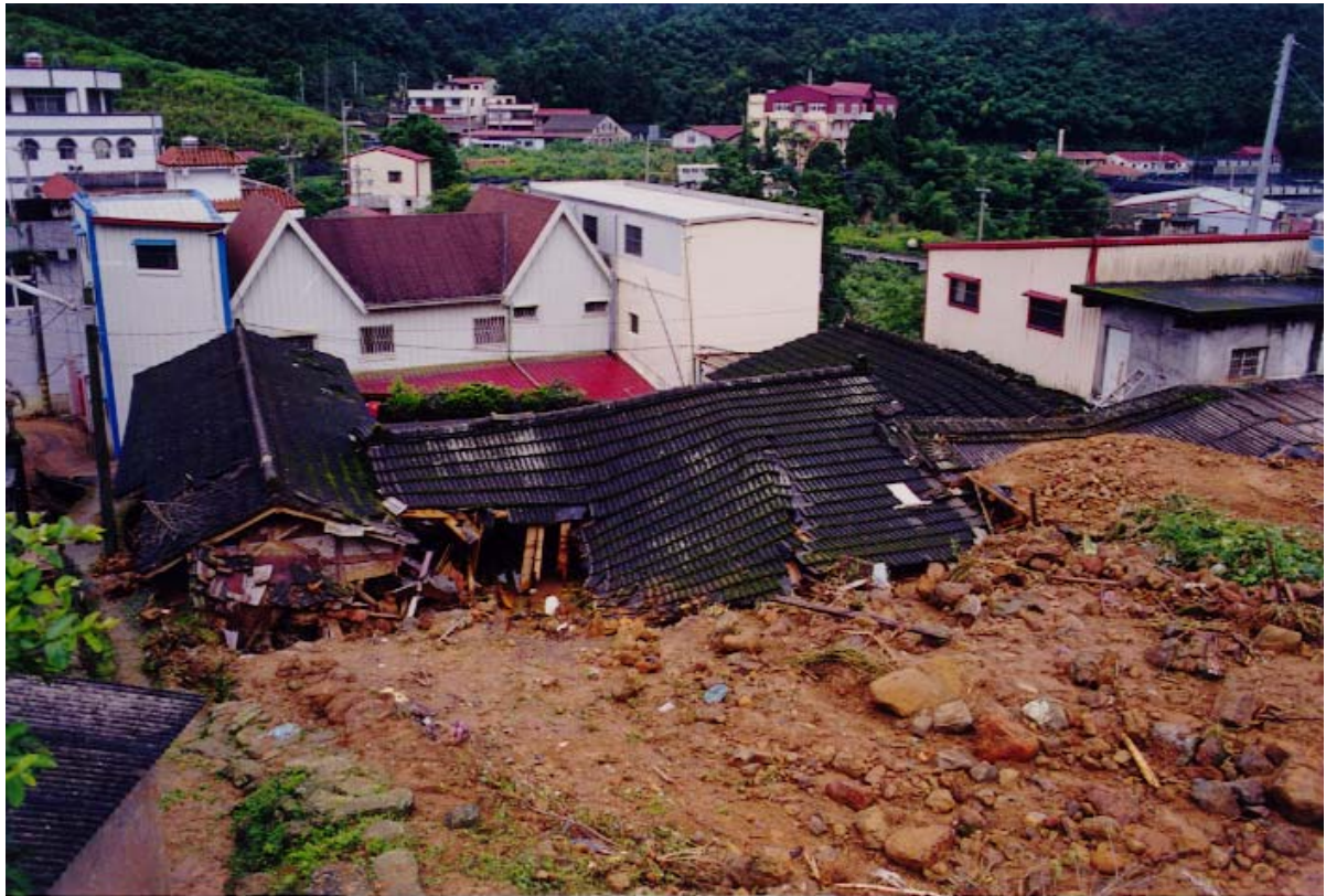
嘉義梅山太平村山崩現場，大量土石直衝而下，不幸沖毀山下一棟三合院宅。
