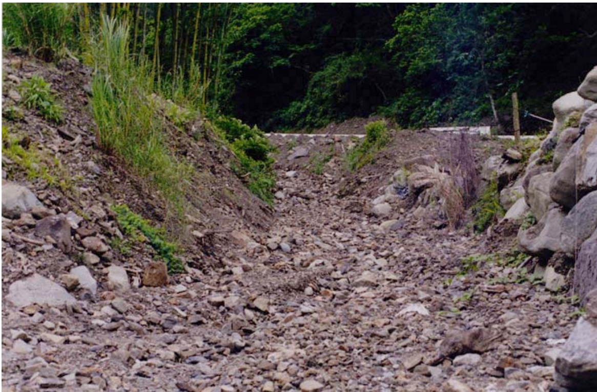
更上游之河床表面砂石相當乾淨，並無砂土置積，植生亦未受影響。
