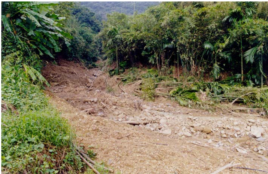
溝谷二側林木橫臥、溝底則為土石、樹木所淤填（分佈圖 p-4）。
