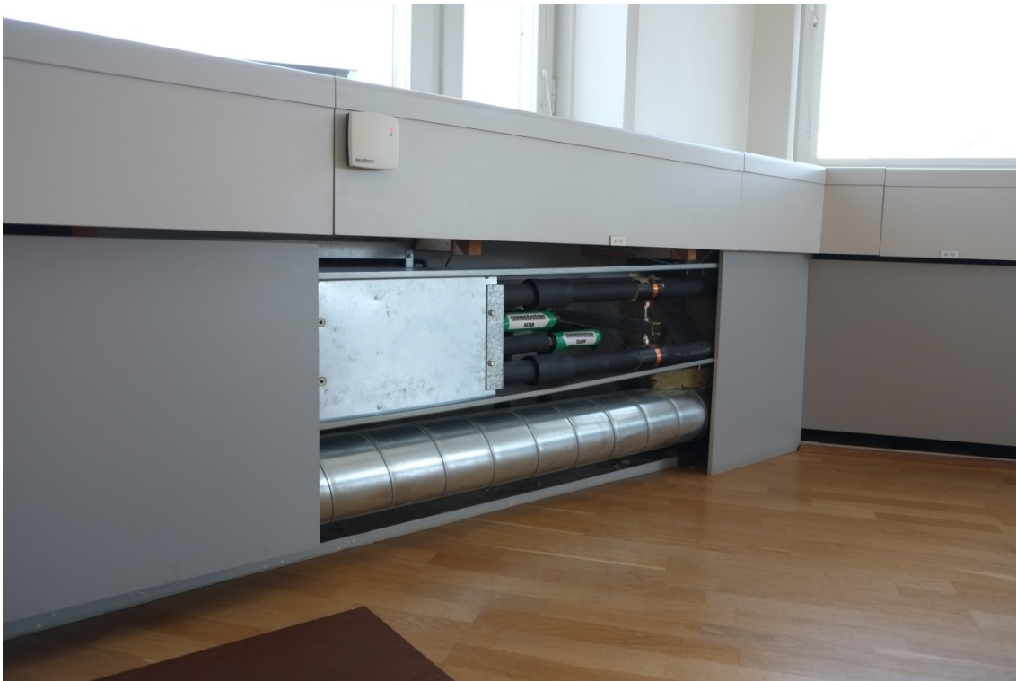
Kabel- och installationsrännor med ventilation är monterade utmed fönsterbänkar på samtliga kontorsvåningar.
