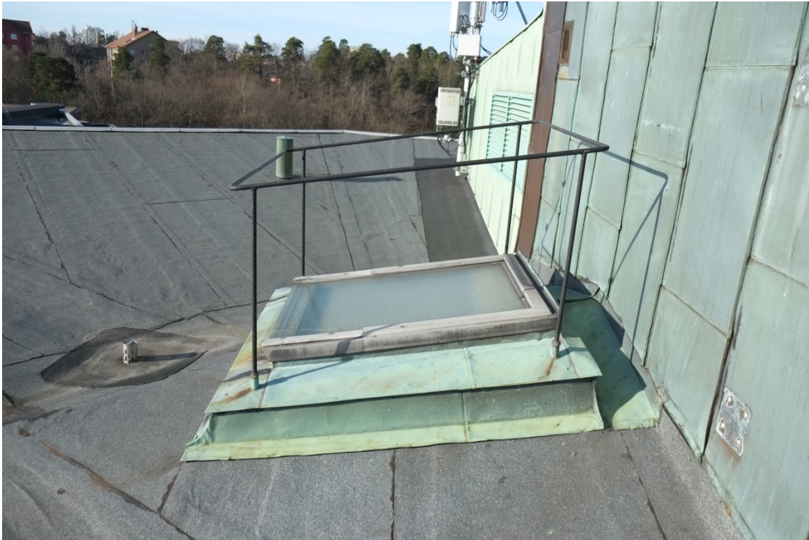
Takets beläggning av papp med ursprunglig röklucka intill den indragna kopparklädda installations- och hissbyggnaden.
