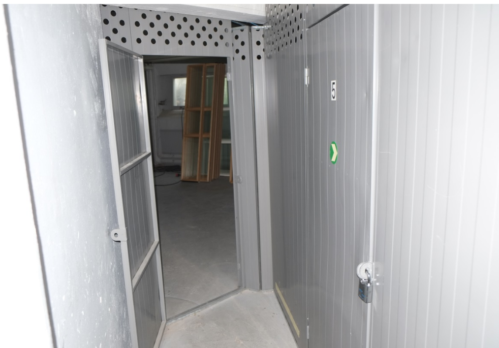
Källaren med enklare väggar i plåt för indelning i olika förrådsytor.
