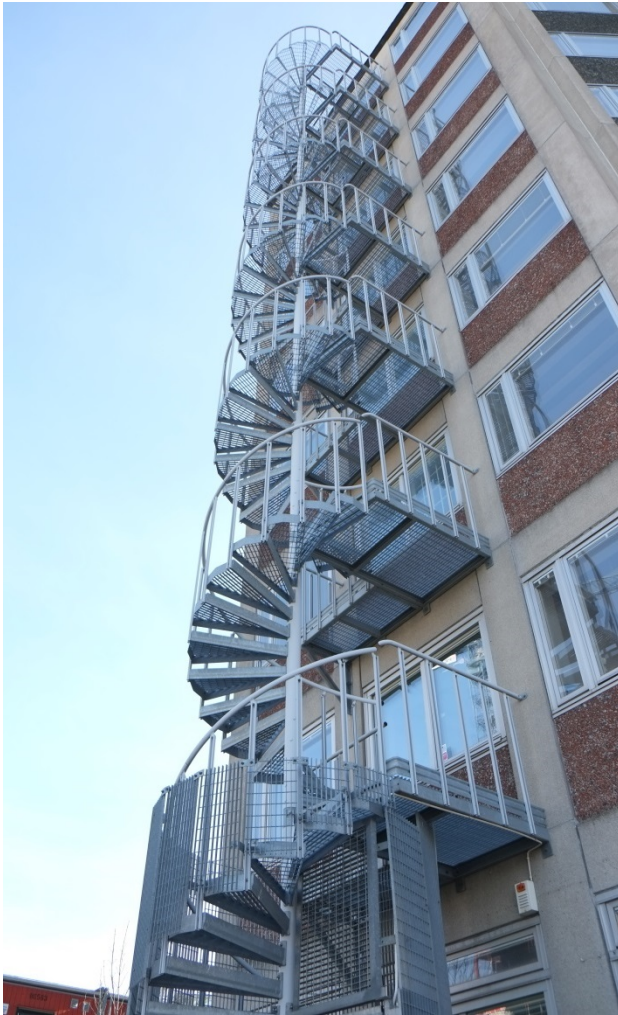
Senare tillagd brandtrappa i förzinkat stål på byggnadens nordvästra fasad.
