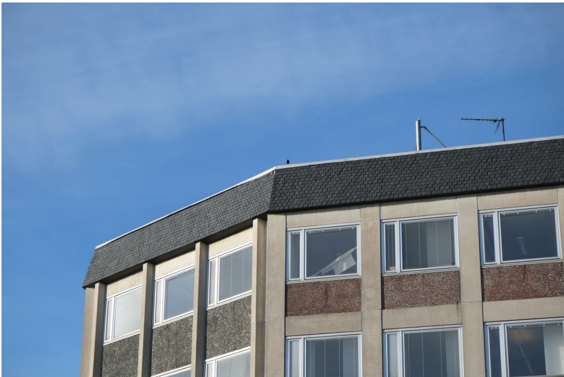
Byggnaden sedd från nordost med fasadens vertikala och horisontella band är klädda i betong med frilagd ballast i olika kulör. Här syns också det sluttande bandet med skiffer runt takfoten.
