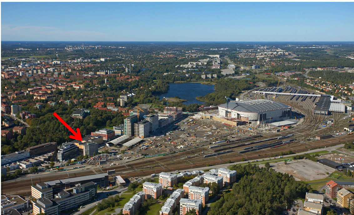
Flygbild över Arenastaden under uppförande av Friends Arena, 2011. Vid pilen syns Oktagonen på fastigheten Pyramiden 4. Framför byggnaden står bågarna till den då ännu ej monterade bron som ansluter Arenastaden med pendeltågsstationen. Mellan Oktagonen och arenan har även Mall of Scandinavia börjat växa upp sedan bilden togs. Foto: Fabege
