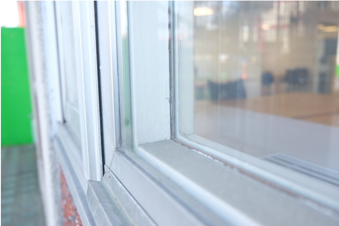
Ursprungliga kopplade fönster med ytterbåge i aluminium, innerbågar i trä.
