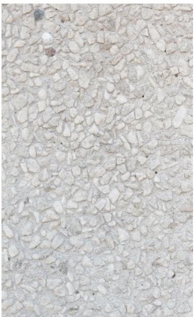
Partier med olika sorters frilagd ballast.
