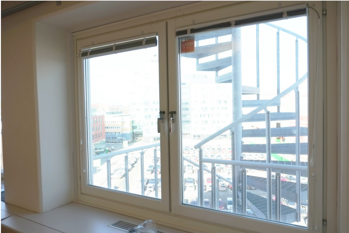
Sidohängda fönster ut mot brandtrappa, lika på samtliga plan.
