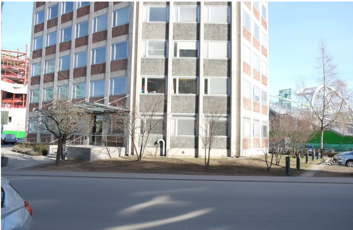
Byggnaden med huvudentrén med senare tillagt skärmtak samt trapp och ramp i granit. Vy från söder.
