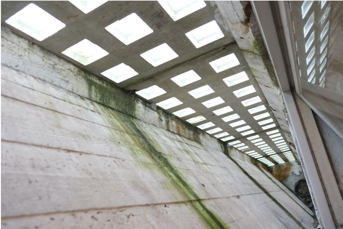
Ljusbrunnen i betong och betongglas som leder ner ljus till källarplanets norra del.
