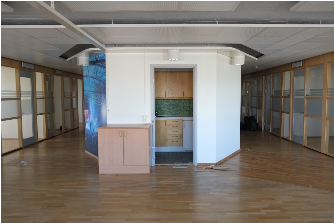
Plan 8 med innertaken där betongbjälklagens brädformar är exponerade mellan akustikplattor och kanalisationer. Pentry centralt och kontor efter ytterväggar.
