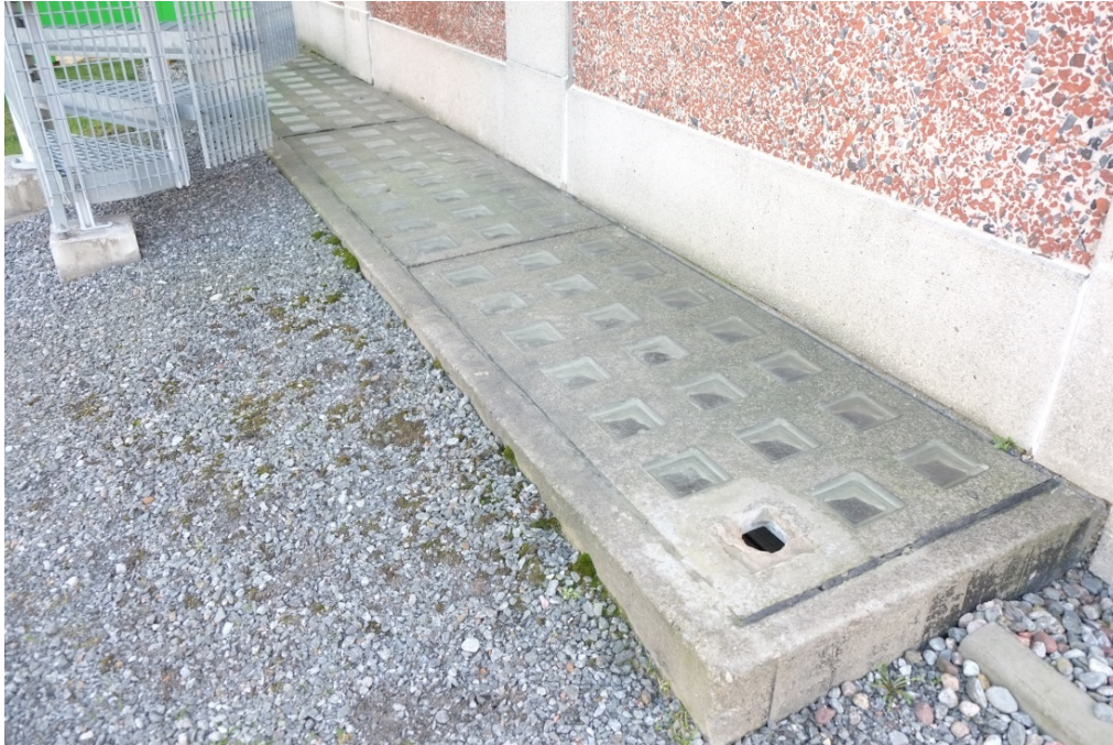
Ljusbrunnen som leder ljus ner i källarplanet i byggnadens norra del, i betong och betongglas.
