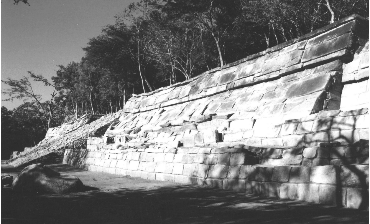
Figura 6 La Estructura B-1 (Vista norte)
