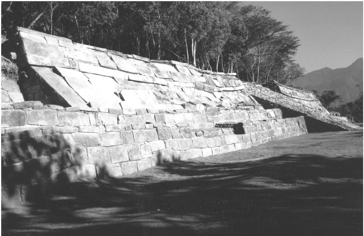
Figura 7 La Estructura B-1 (Vista sur)
