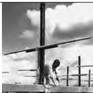
El Campo radar dipoles
