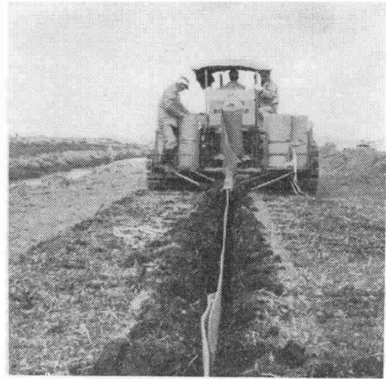
写真-3 止水板埋設機(その1)
