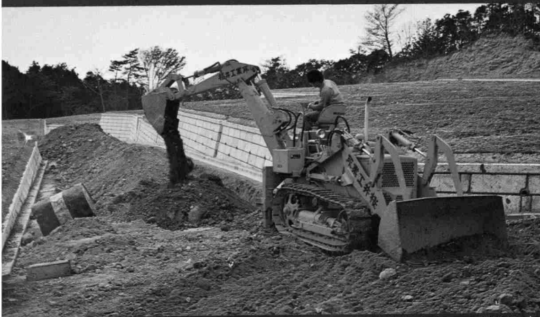
BS3バックホー（配管工事）
