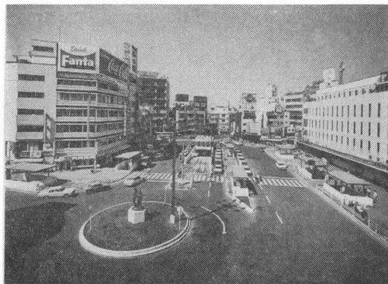
写真-2 池袋駅西口地下駐車場出入口
