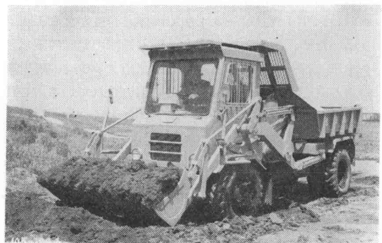
写真-4 セルフローダ付作業車
