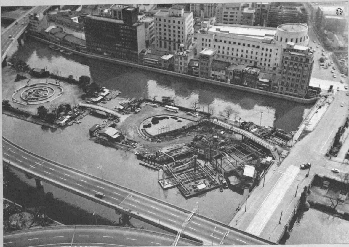
⑬ 池田バイパス ( L=3,350\text{m} W=23\sim 24\text{m} ) 阪急宝塚線(石橋駅同箕面線) 国道176号線連続立体化工事: 国道171号線の箕面市~池田市~伊丹市バイパス
