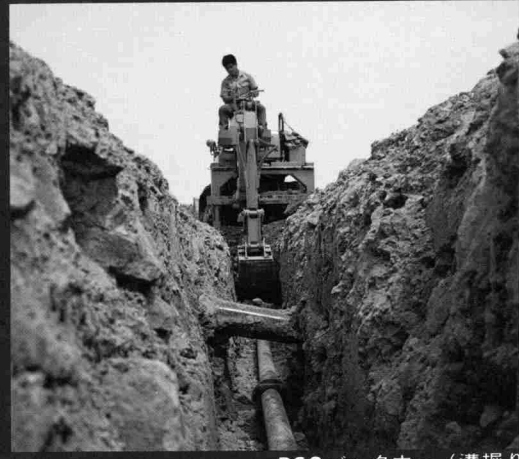
BS3バックホー（溝掘り）
