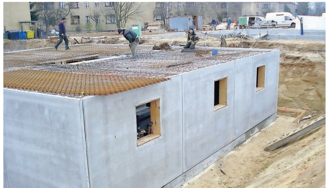
Errichtung eines Wohnhauses mit Vollkeller. Foto: Busche
