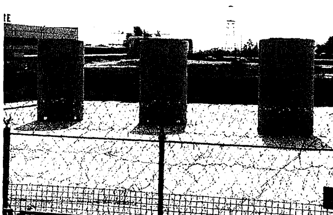
Рис. 27. 2. Площадка хранения с установленными бетонными контейнерами с ОТВС.
