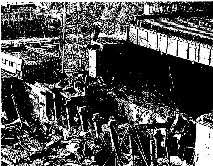
Рис. 4.1. Фотография разрушений блока № 4 Чернобыльской АЭС в Украине (фото - август 1986 г.).
