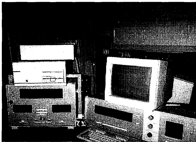
Рис. 8.7. Общий вид автоматизированной системы контроля радиационной обстановки (АСКРО) смонтированной на ЧАЭС (СРРМ-2).
