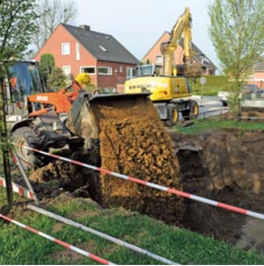
■ Making-of Unterflur: Nach Fertigstellung der Baugrube ...
