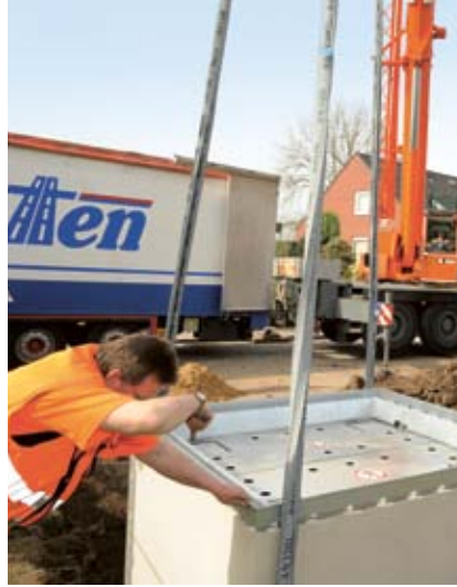
■ ... werden die Betonschächte milli- metergenau eingepasst, ...
