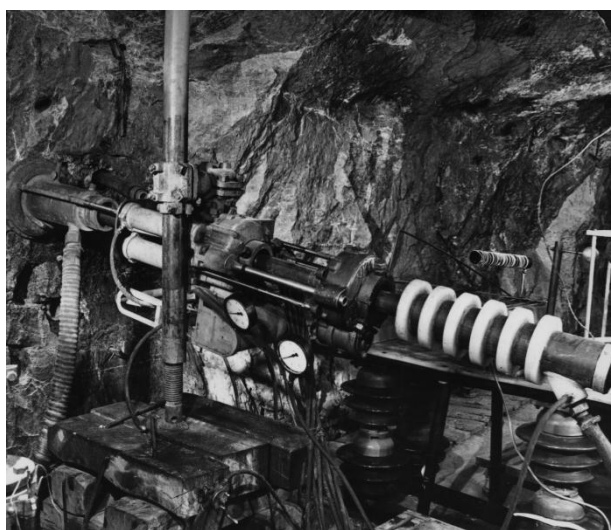
Рис. 15. Установка электроимпульсного бурения, Кировский рудник ОАО «Апатит»
