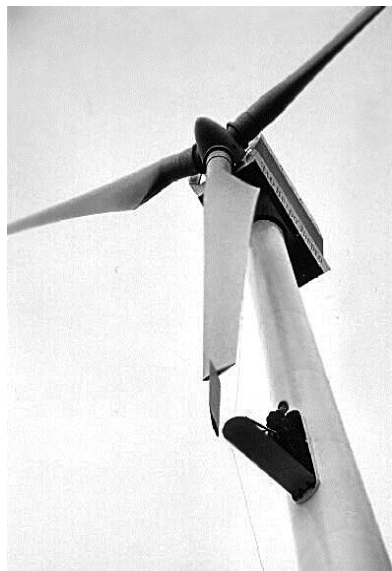
Рис. 3. Осмотр аэродинамической тормозной системы ветроустановки (высота 30 м)
