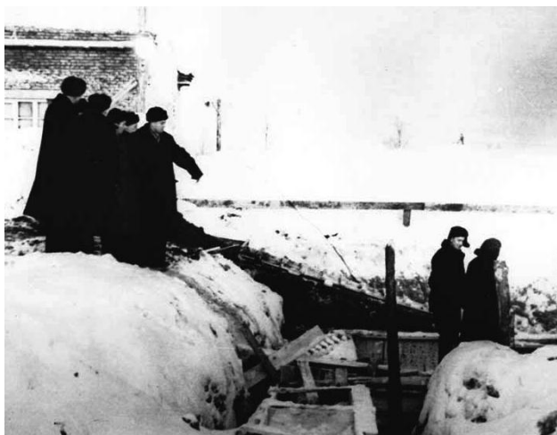
Рис. 4. Март 1956 г.: руководство КФАН СССР во главе с чл.-корр. А.В. Сидоренко контролирует ход строительства здания сейсмостанции «Апатиты», осуществляемого по проекту Г.Д. Панасенко (справа в верхней группе)
