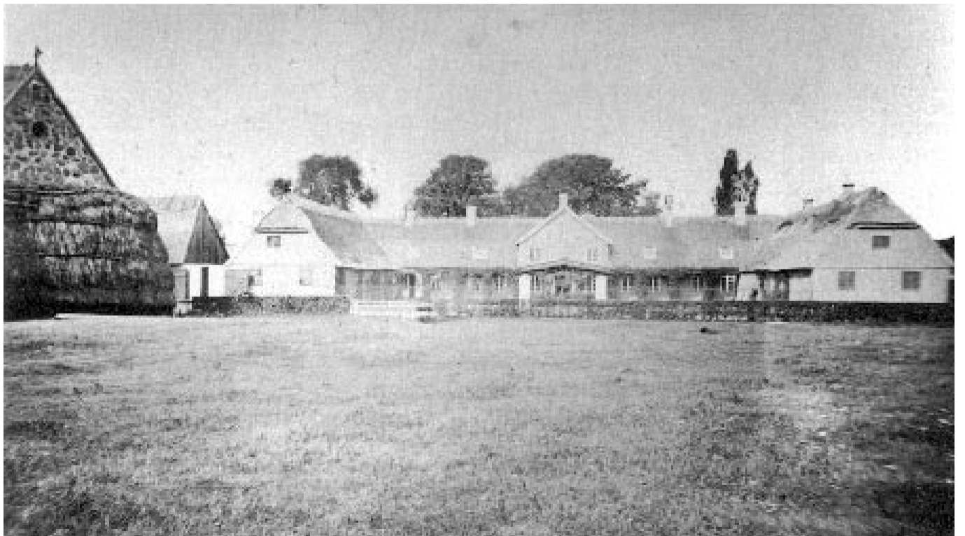
Gurrehus set fra syd omkring 1875. Det trefløjede gårdanlæg blev revet ned i 1881, hvorimod avlsbygningerne, der delvist ses til venstre først blev nedrevet i 1918. Kampestensbygningen, der ses længst til venstre i billedet var gårdens lade.
