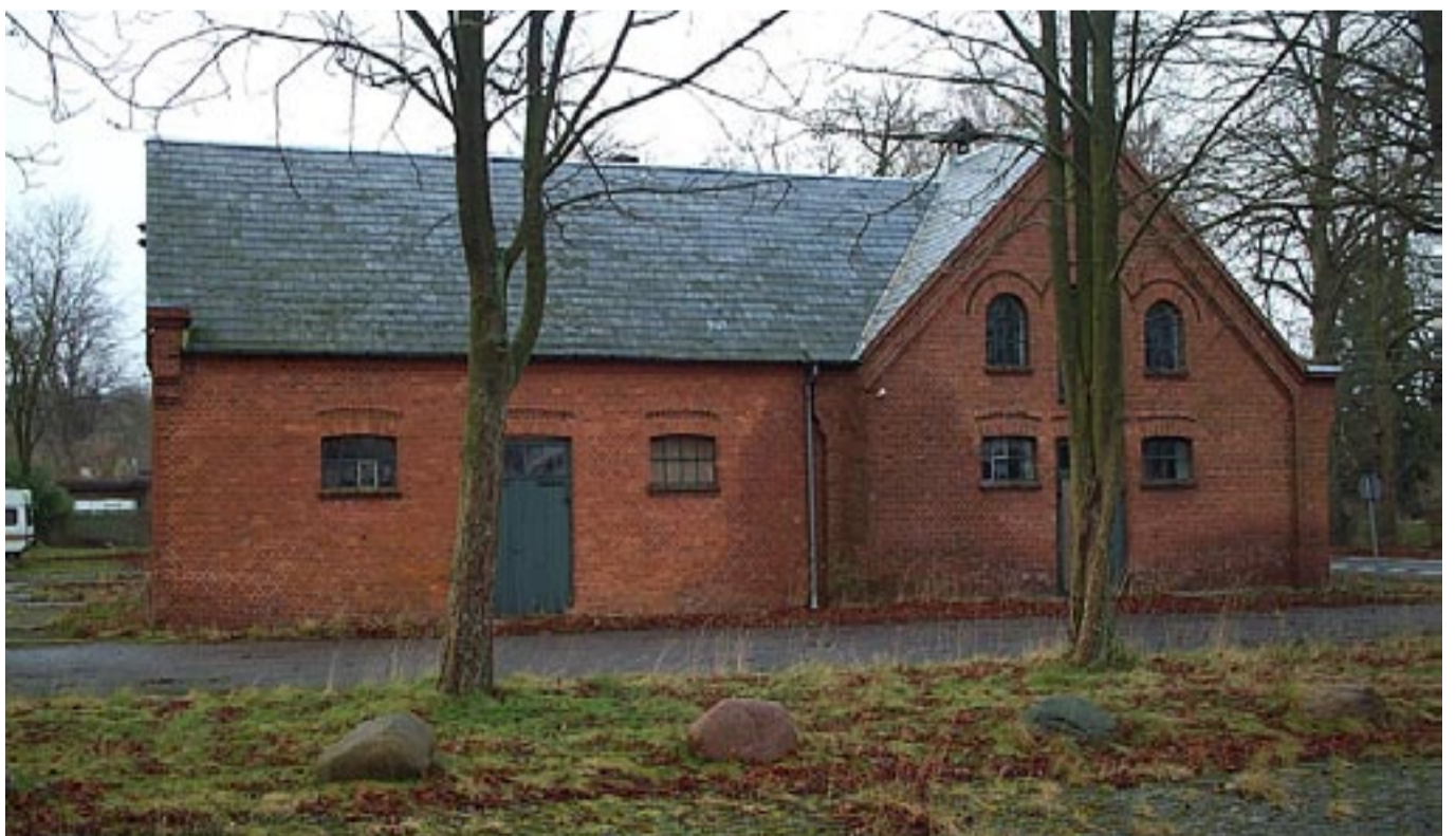
På sydsiden af Gurrevej opførtes i 1916 denne staldbygning med tilhørende kuskebolig.
