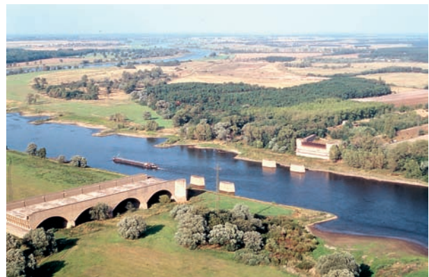
Die Kanalbrücke vor dem Abbruch
