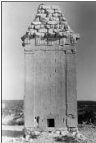
Abb. 8: Hellenistischer Grabbau. Südseite
