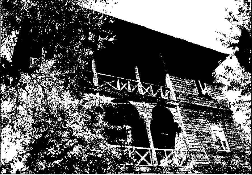
Resim 4: Artvin-Oruçlu Köyü eski gümrük binası, ön cepheden
