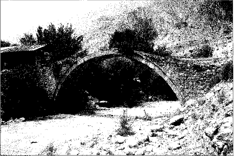
Resim 6: Ardanuç-Avcılar Köyü Şavlet Mahallesi Köprüsü, genel
