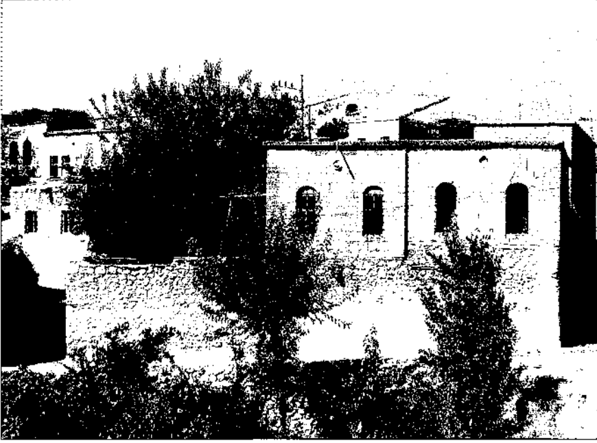
Resim 5: Fıstıközü Köyü, caminin yer aldığı yapı adasının kuzeyinde yer alan Şih Müslim Öz Evi'nin doğu cephesi
