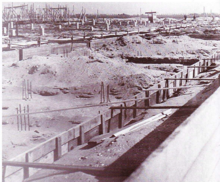
Bekistingwerken van eengezinswoningen aan de Portugalstraat, 1962 (Kennemer Atlas)
