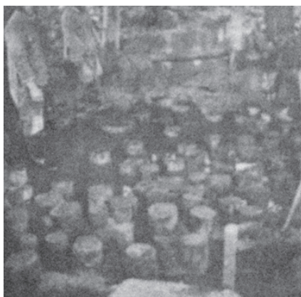
写真5 Exposed wooden piles (修復時に現れた木杭)
