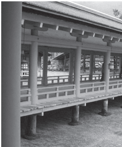
写真2 Wooden pillar upon stone (礎石および柄柱)
