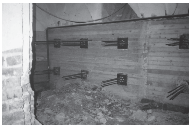
写真8 Concrete side panel to constrain foundation (Avellan, 1995) (6) (基礎拘束用のコンクリート側壁パネル)
