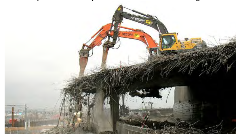
Rivearbeider på betongbru
