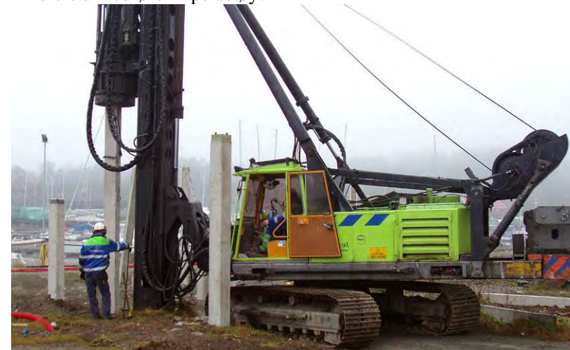
Ramming av betongpeler
