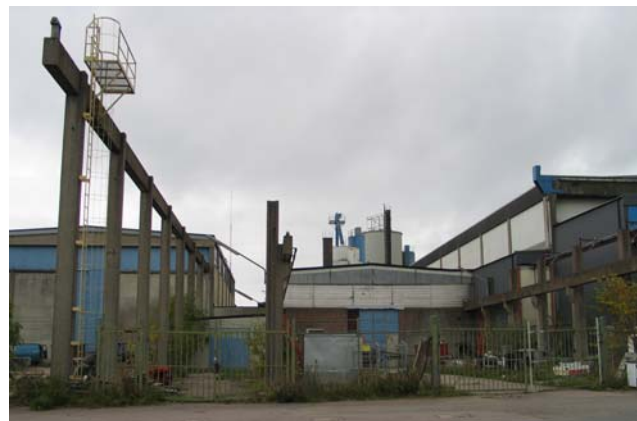
T.v. Skånska cements elementfabrik i Kalmar 1965 i full drift. Observera hur byggnaden har öppning i mitten och hur traversen som fraktade betongelementen börjar inne i byggnaden (Antilopen 27). T.h. Fabriken idag. Den lägre delen i mitten är den första fabriksbyggnaden från början av 1960-talet. Utbyggnadsetapp 2 är den högre delen till vänster och etapp 3 den stora byggnadskroppen till höger i bild.
