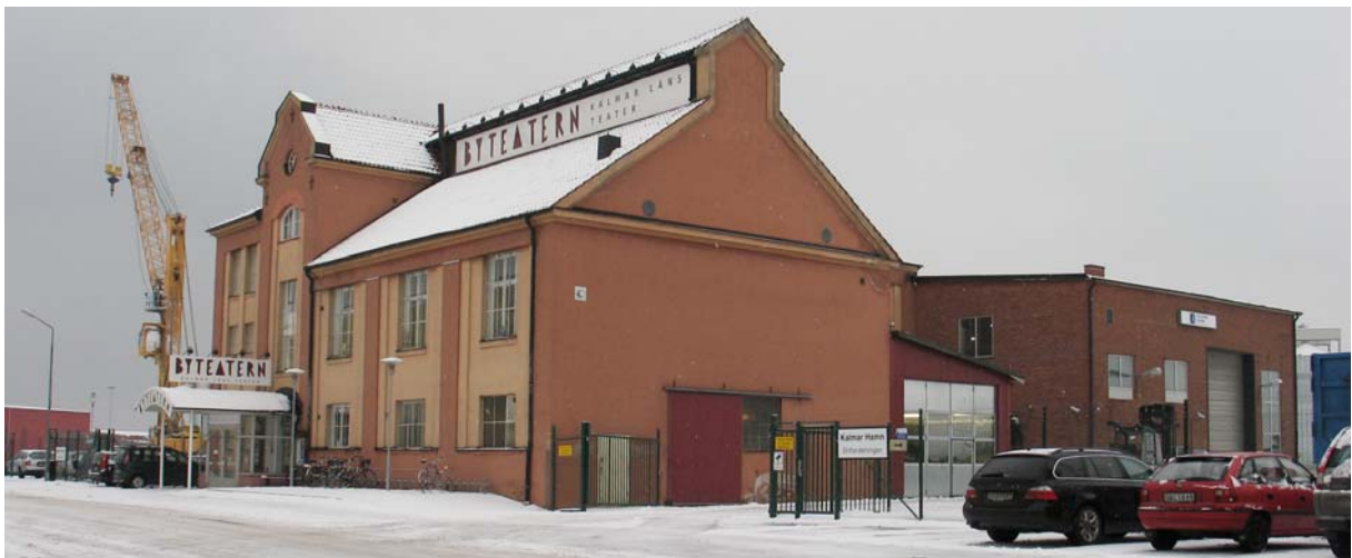
Delar av Margarinfabriken Sveas oljefabrik, som idag tjänar som teaterbyggnad. Byggnaden uppförd 1925. (Oljefabriken 3)
