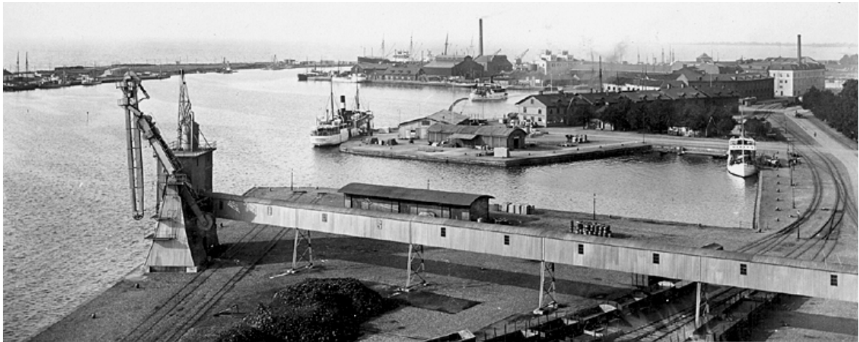
Kajen och utlastningen vid Kalmar ångkvarn. Kvarnen lokaliserades med tanke på sjöfarten, men då järnvägen byggdes fick man direktanknytning till denna genom industrispår. I bakgrunden syns margarinfabriken (t.h.) och dess oljeextraktionsverk (centralt). Foto ur Kalmar Läns Museums arkiv.
