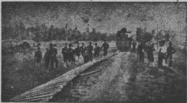
barisan „muslimin“ bekerja malam, membongkar djalan kereta api dan memotong kawat telepon. . . . .
