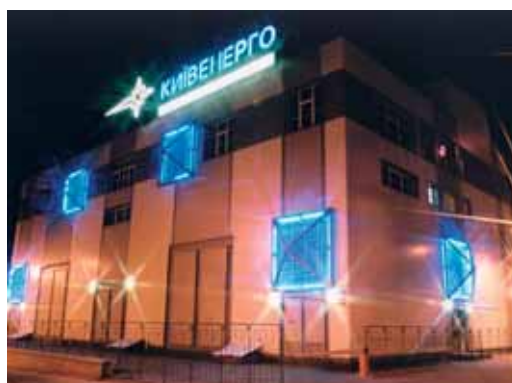
Елегазова підстанція "Центр"
