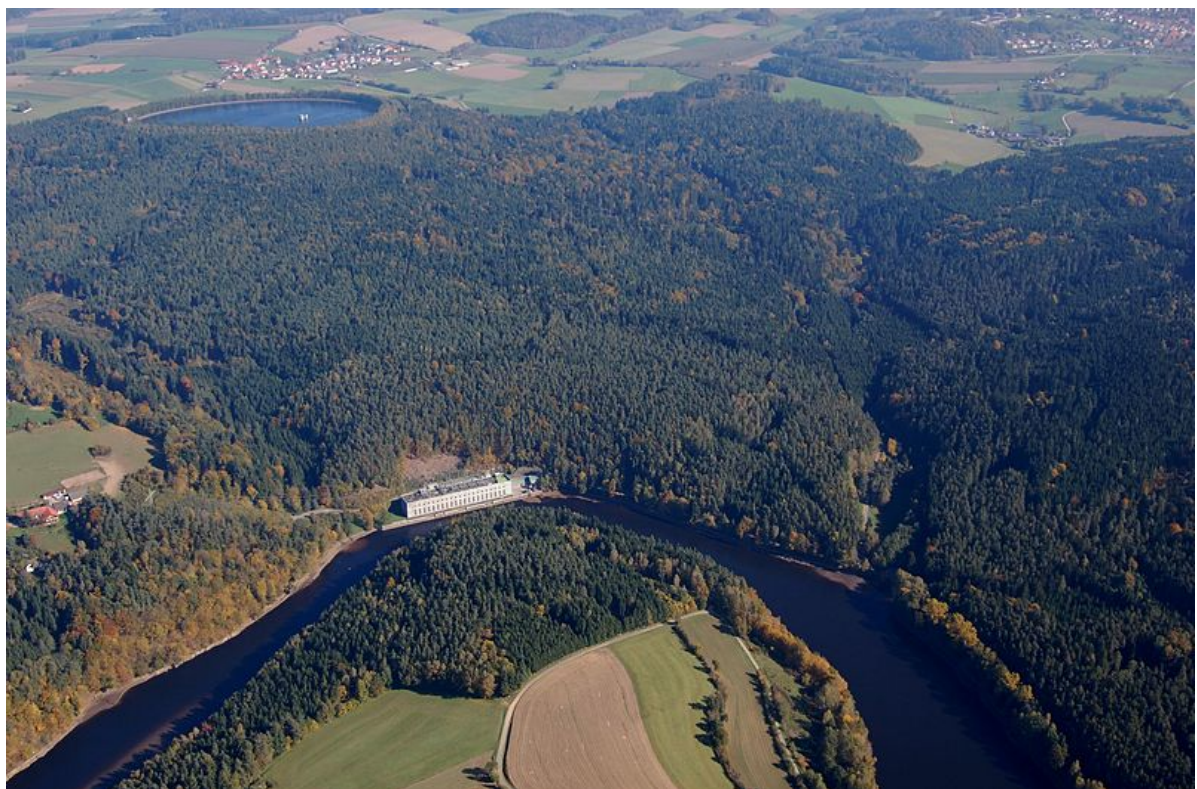
Abbildung 1: Beispiel Pumpspeicherwerk Reischach mit Hochspeicher Rabenleite (© Alois Köppl, Gleiritsch http://online-2000.de )
