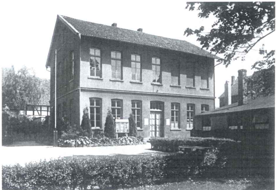
Ehemaliges Berufsschulgebäude am Waisenhausplatz in Lemgo
