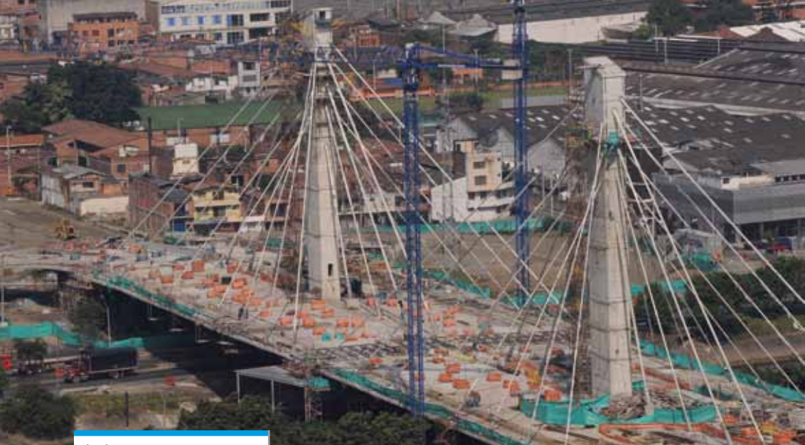
▼ Puente Gilberto Echeverry, en la calle 4 sur.
