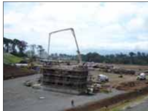
Land Tower Pedestal Concrete Pour
