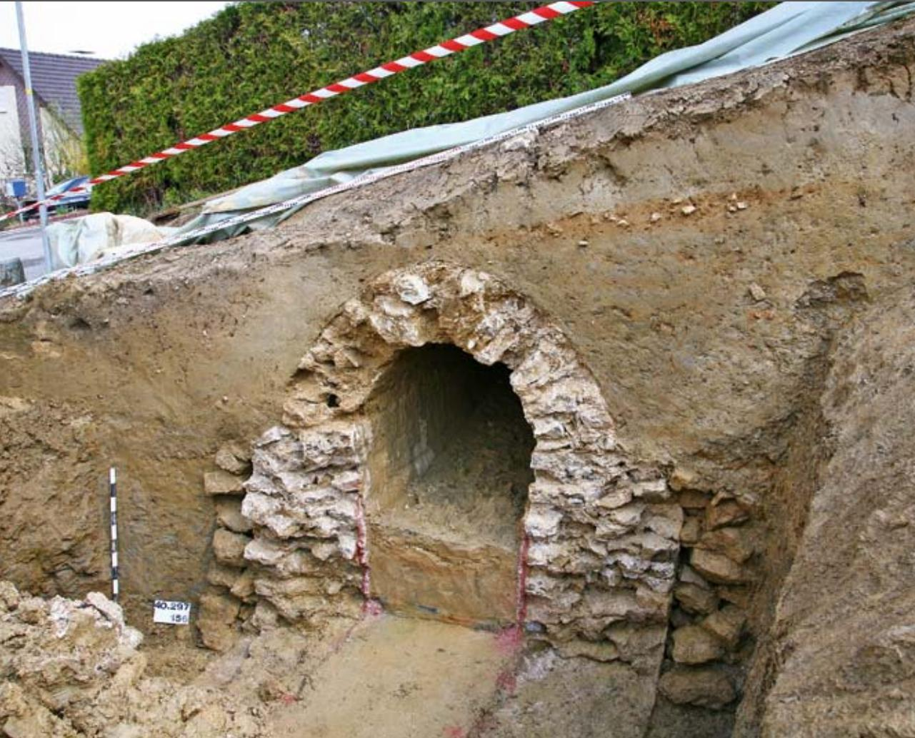
Der Querschnitt durch die Wasserleitung verdeutlicht deren Aufbau in idealer Weise. Die hellbraune Schicht über dem höchsten Punkt des Gewölbes zeigt das römische Gehriveau nach dem Zuschütten der Leitung durch die Erbauer. Die untersten 15 Zentimeter der Verfüllung in der Leitung haben sich noch in der spätesten Benützungszeit abgelagert.
