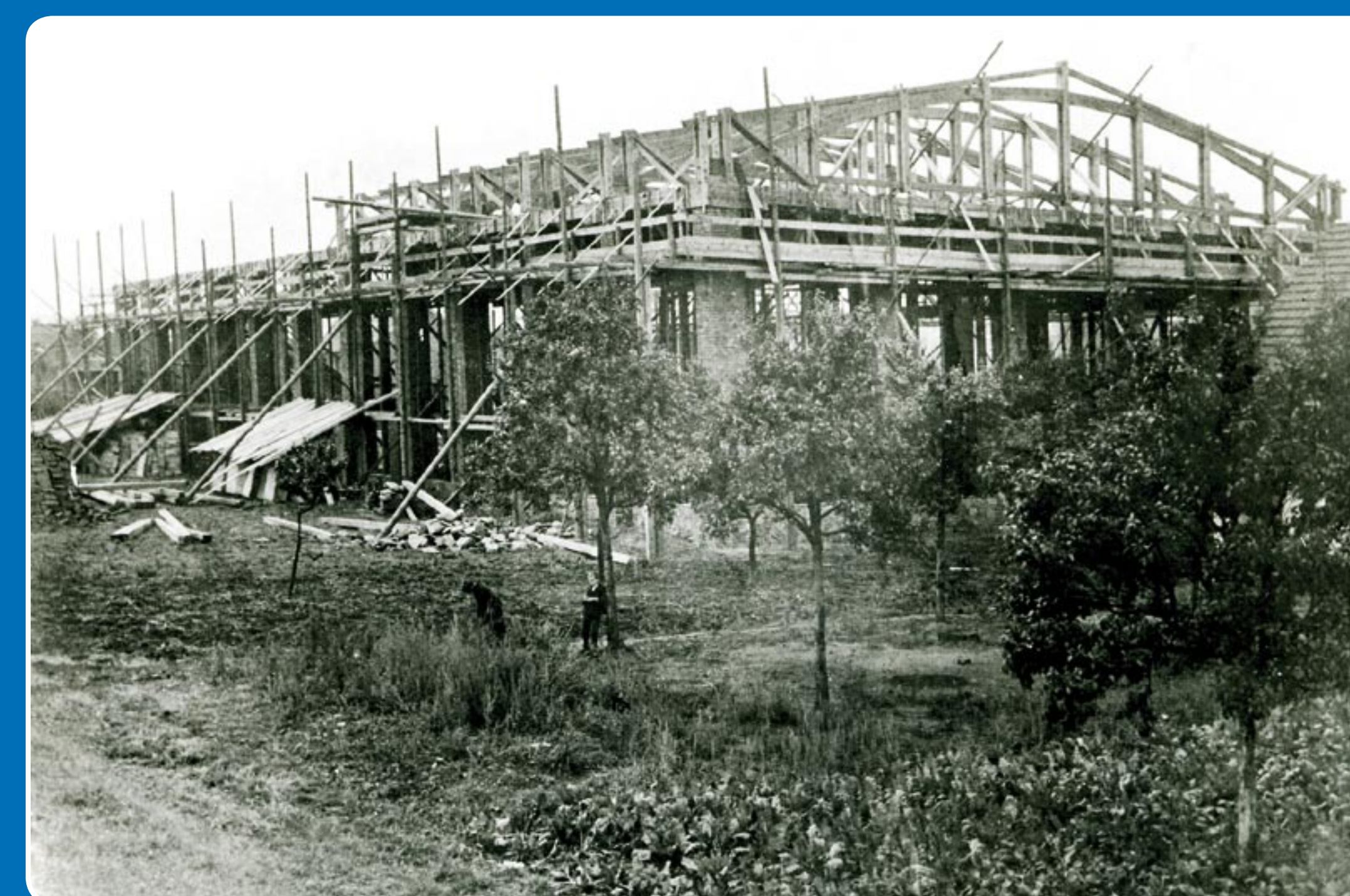
Stavba sklárny 1920–1921 * Glassworks construction 1920–1921 * Bau des Glaswerkes, 1920–1921
