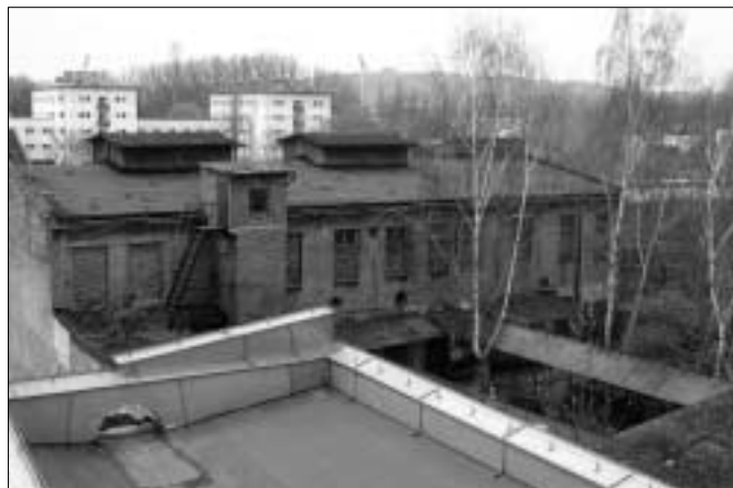
Widok hali pralni chemicznej „Tęcza”
