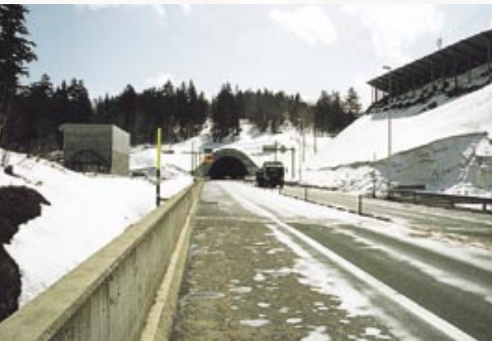
北大雪トンネル坑口（上川町側）
