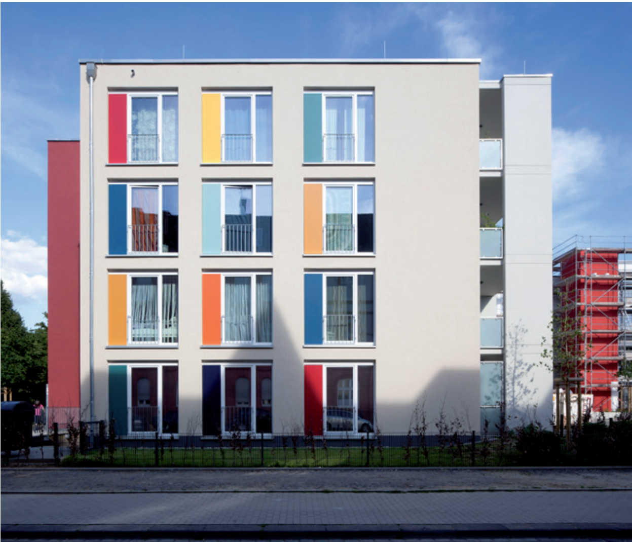
Klimaschutzsiedlung Ückendorf, Gelsenkirchen
