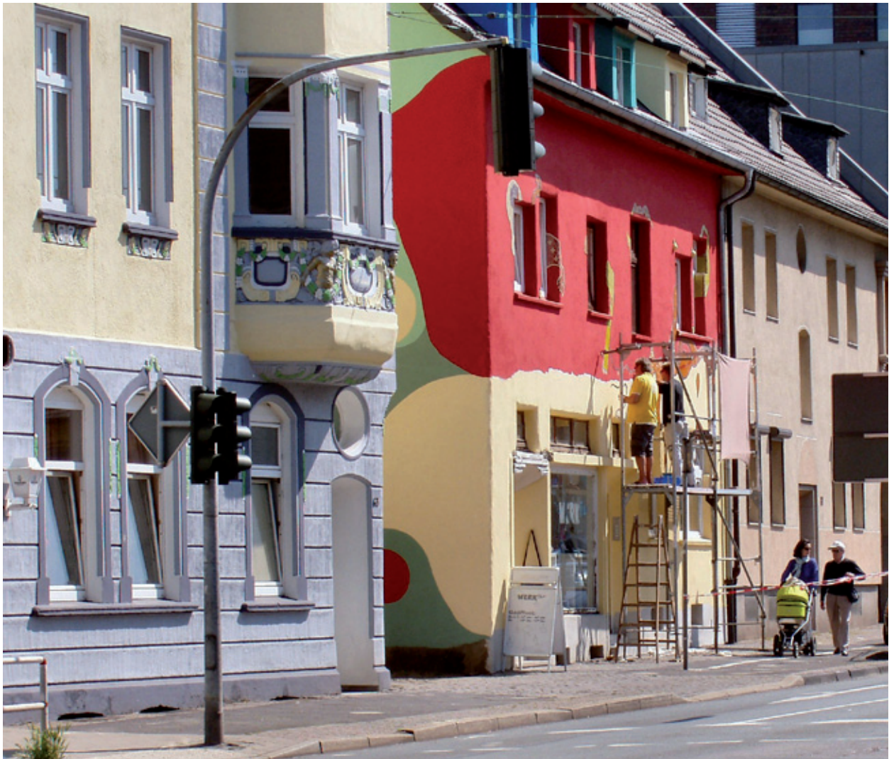
Fassadenerneuerung in Wattenscheid, Bochum
