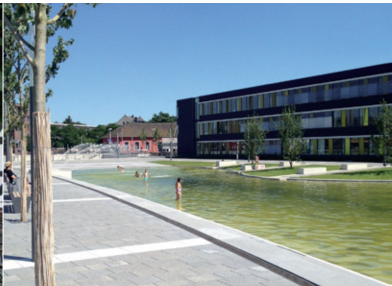
Am Nierspark - Stadttumbau West, Geldern
