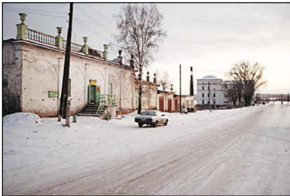
Предзаводская площадь. Вид на стену с балюстрадой и вазами и на домну. Фото 2008 г.
