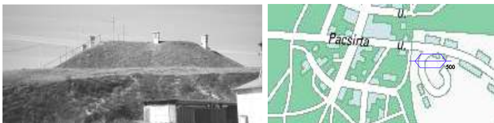
Az eredeti építésű, jelenleg a Fővárosi Vízművek Rt tulajdonát képező víztározó
