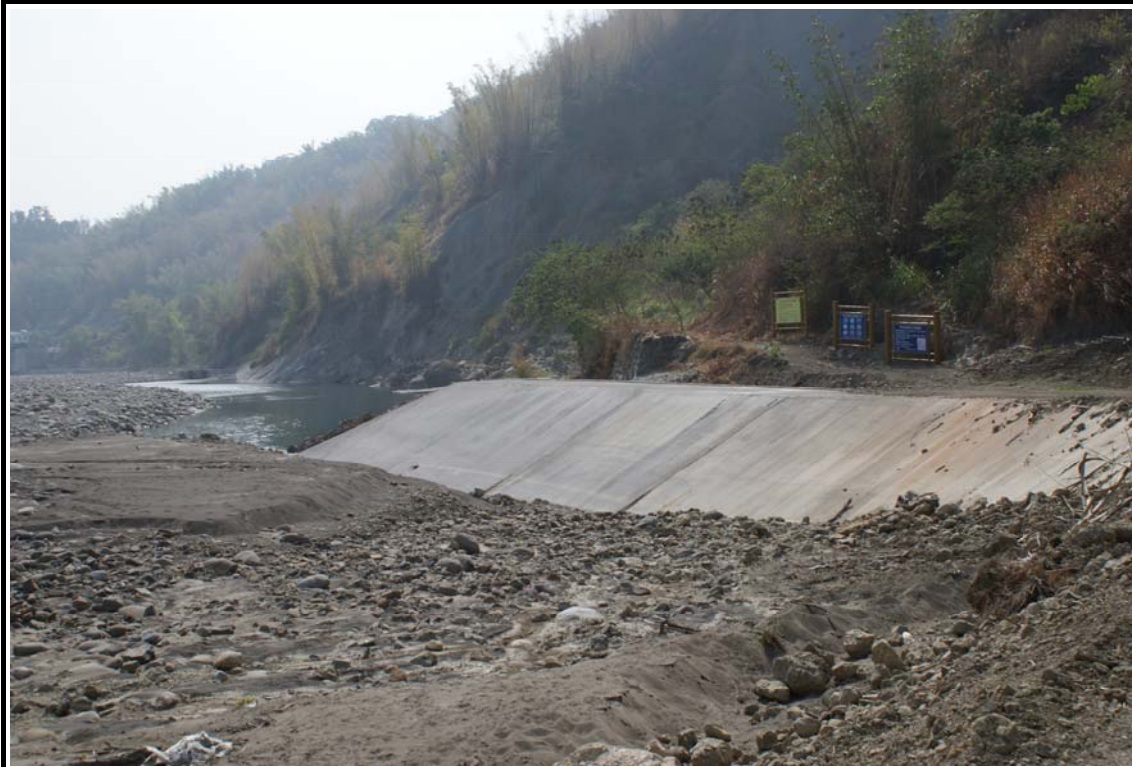
護岸工程構造物
