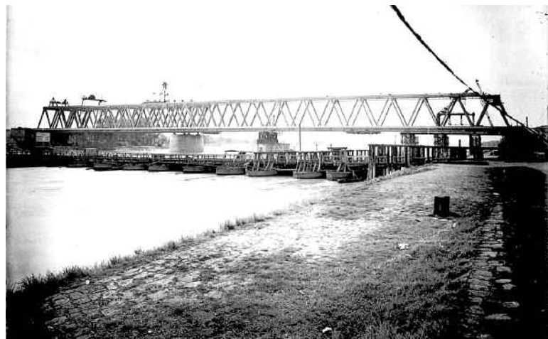
Alte Eisenbahnschiffsbrücke über den Rhein bei Pfortz sowie die neue Rheinbrücke (im Bau, 1937/38)
