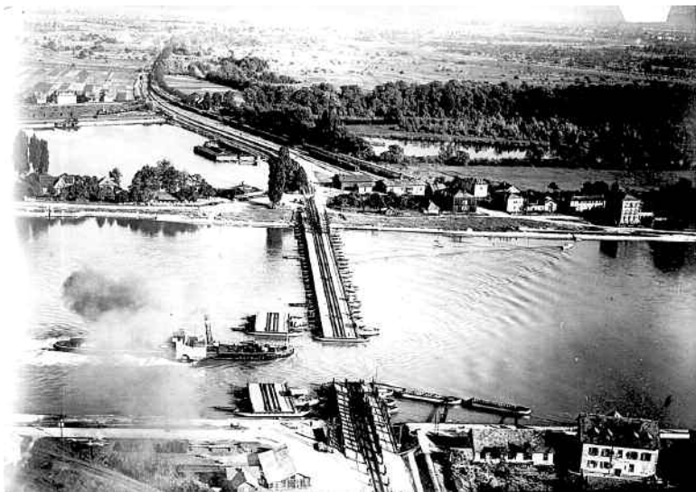
Alte Eisenbahnschiffsbrücke über den Rhein bei Pfortz (bis 1938)
