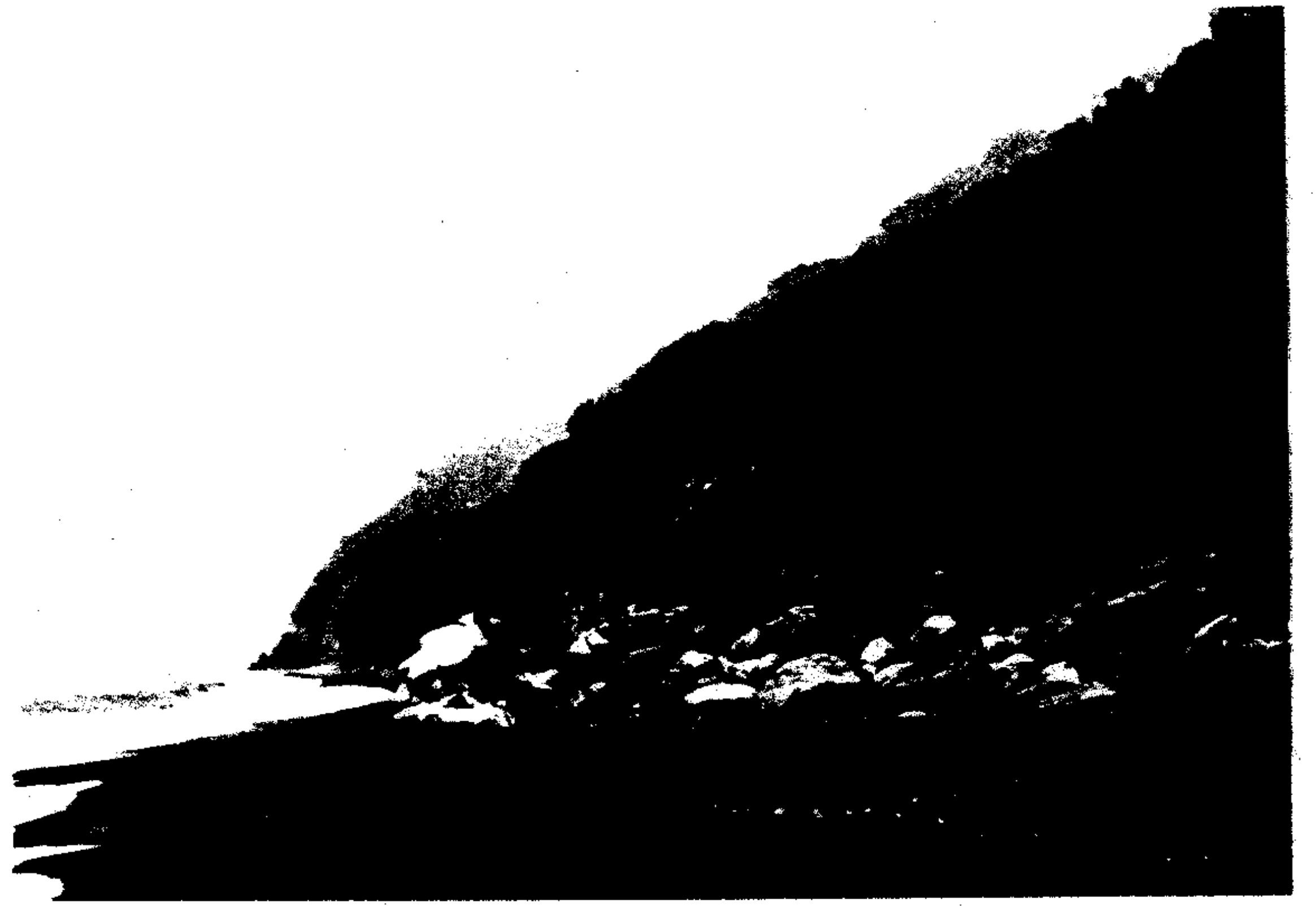
照片十六·落石堆積於坡腳，其範圍即為落石危險區，尤於地震之時或連續降雨之後，危險性更大。（II區）
