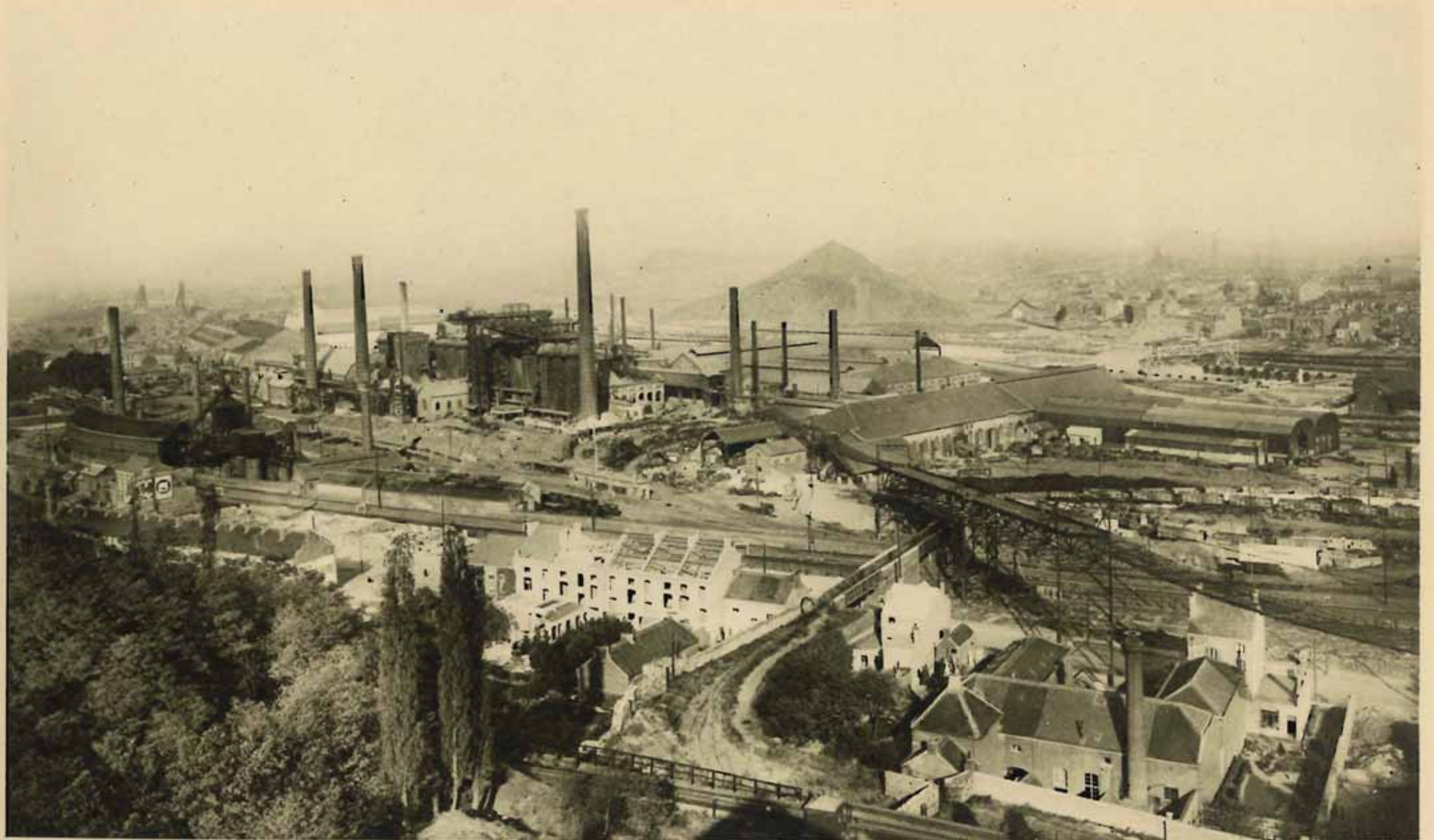
VUE GÉNÉRALE DE L'USINE.
