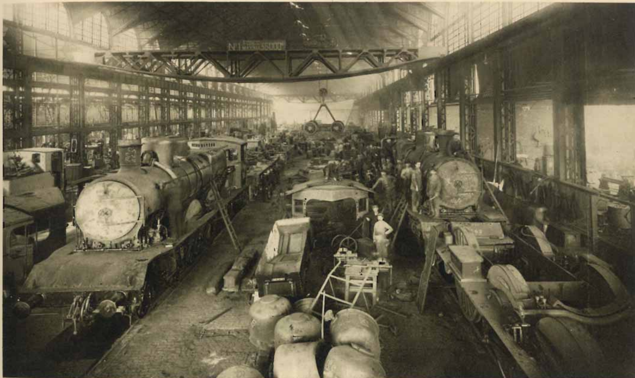
MONTAGE DE LOCOMOTIVES, HALLE N° 2
