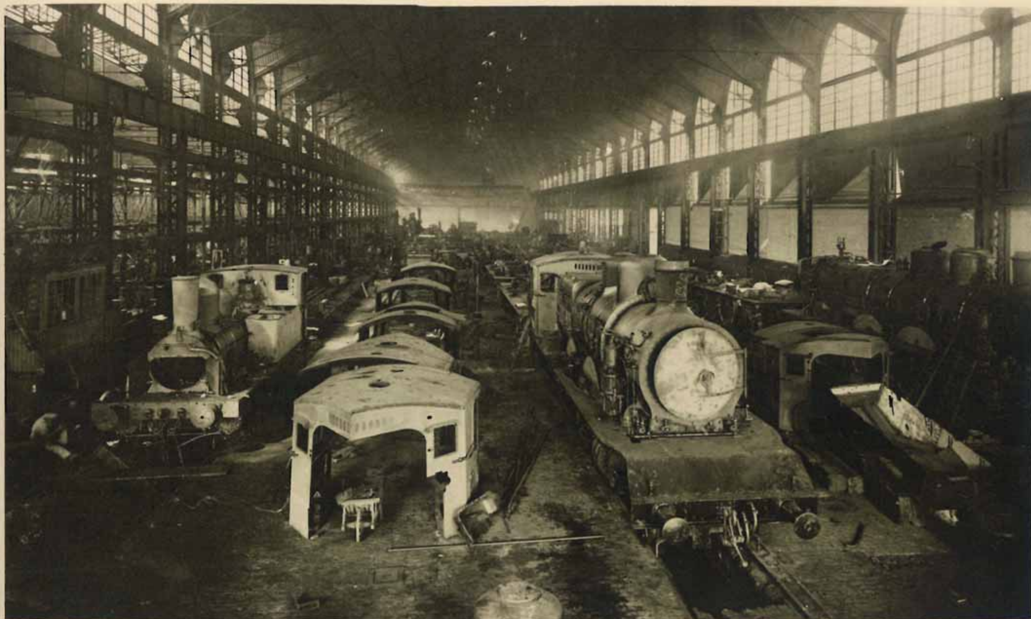
MONTAGE DE LOCOMOTIVES, HALLE N° 1
