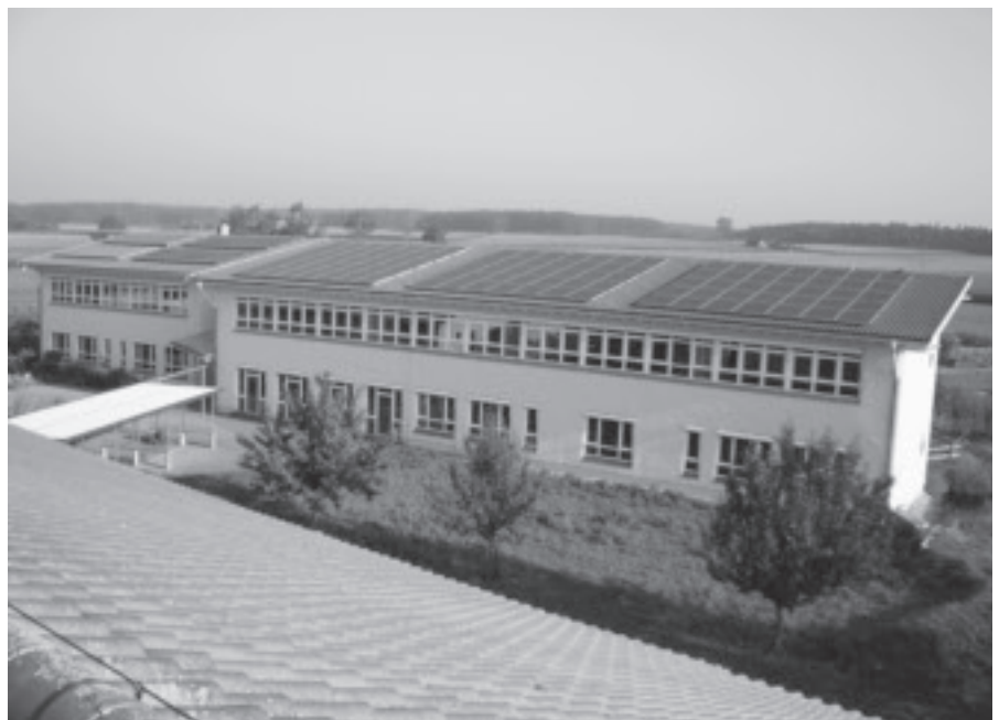
Die Bürgersolaranlage wurde auf den Dächern der Grundschule, der Schulporthalle und des Feuerwehrgerätehauses installiert.
