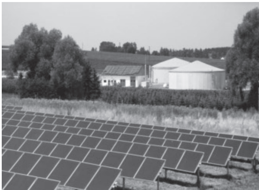
Ein Bild mit Symbolcharakter: Solarpark und Biogasanlage beim Maierhof im Gemeindegebiet Buttenwiesen stehen stellvertretend für die Energieaktivitäten der schwäbischen Kommune.
