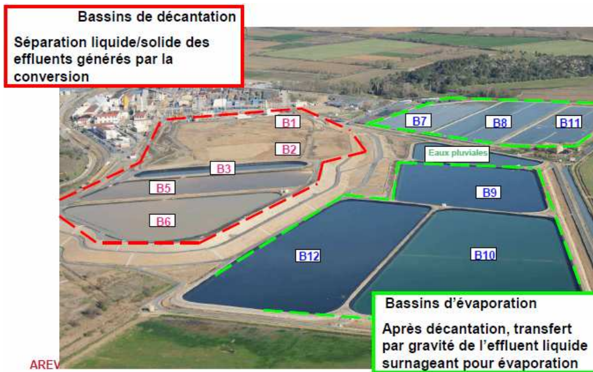
Figure 3 : Les différents bassins de l'Établissement de Malvesi (photo prise en direction du nord, document transmis aux rapporteurs par le maître d'ouvrage).
