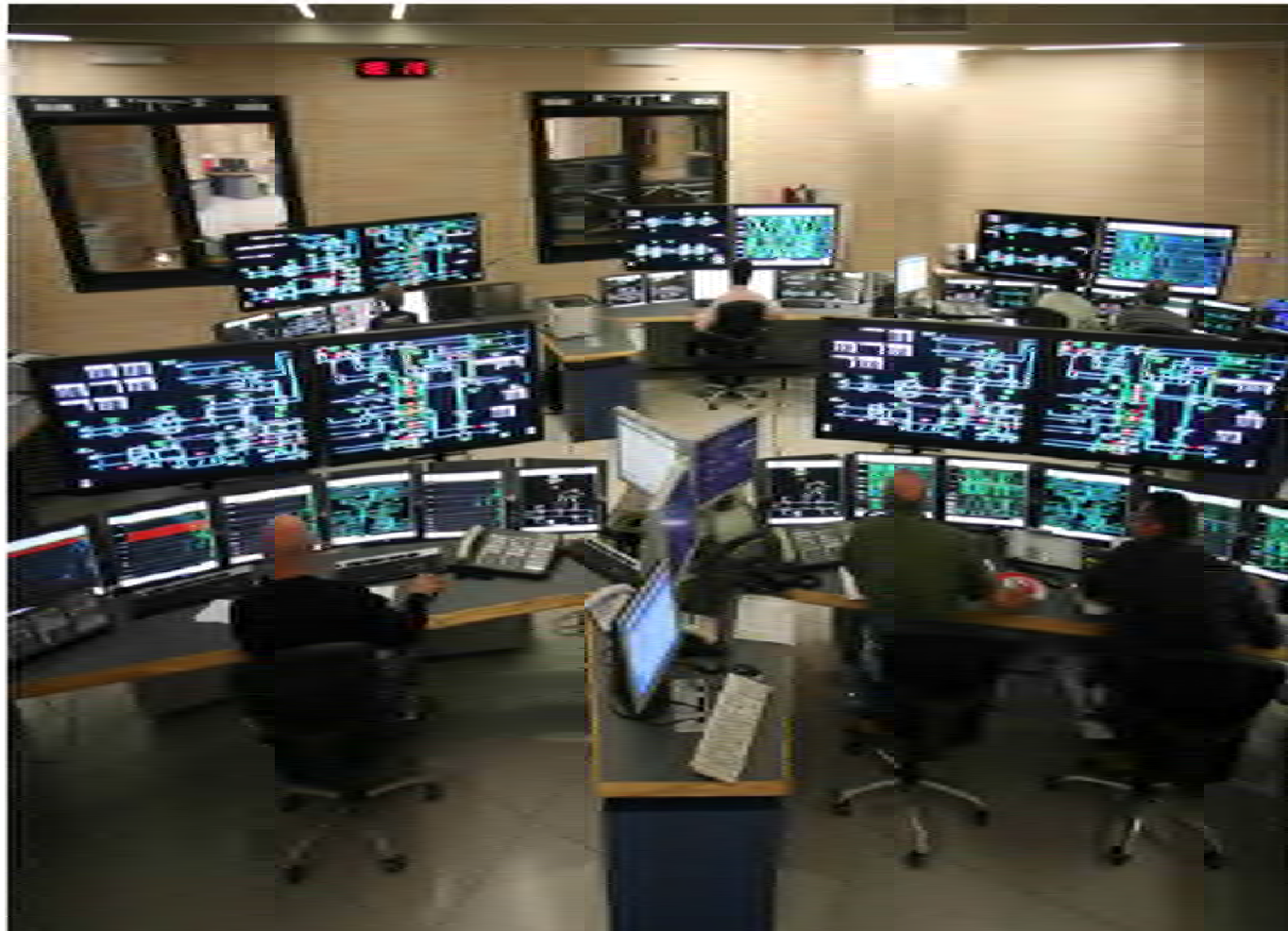
Veduta dell'area di controllo della circolazione
