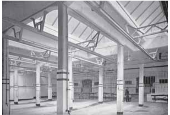
Blick in die Schweineschlacht- halle. Die Glasdächer sorgen für eine ausreichende Licht- versorgung.
