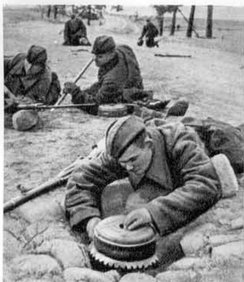
Саперы устанавливают противотанковые мины на подступах к Ленинграду 1941 г.
