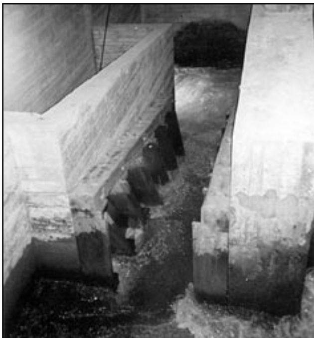
Figur 17. Hunderfossen kraftverk. Motstrømstrapp i dam.
