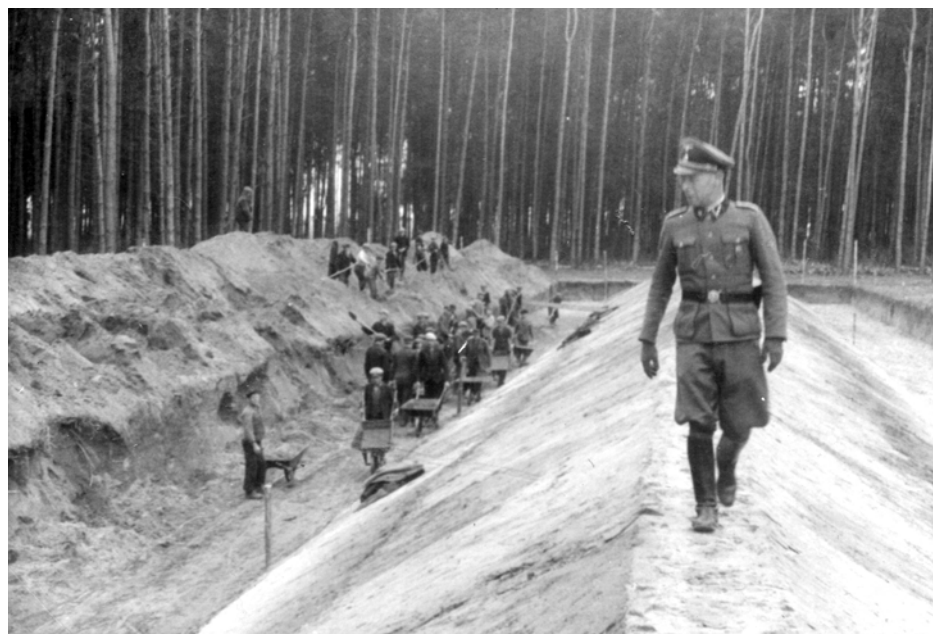
Hans P. auf der Baustelle des Schießstandes BArch B 162/401, Bild 4
