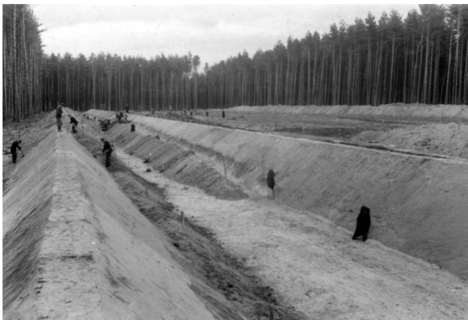
Baustelle der Schießstände im Anfangsstadium. BArch B 162/401, Bild 3
