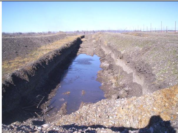
Trinchera excavada en predio para futura disposición de RSU. El agua podría ser aflorante.
