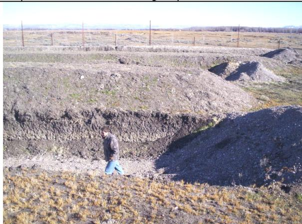
Trinchera tipo – La persona permite una relación de la profundidad de las 7 trincheras excavadas.
